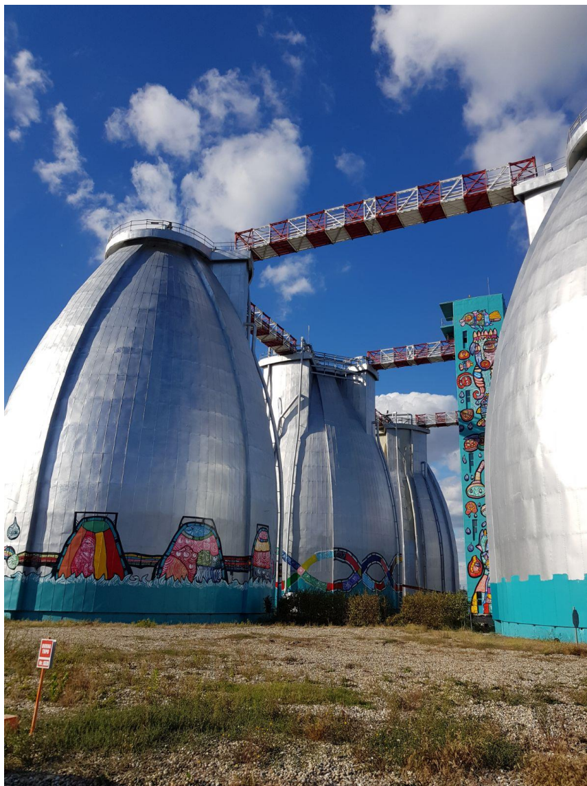
Vyhňovací nádrže na ČOV v Rumunsku
