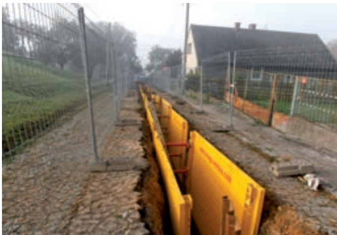
Obr. 4: Dobrovice, kanalizace – výstavba stoky D v Týnci
