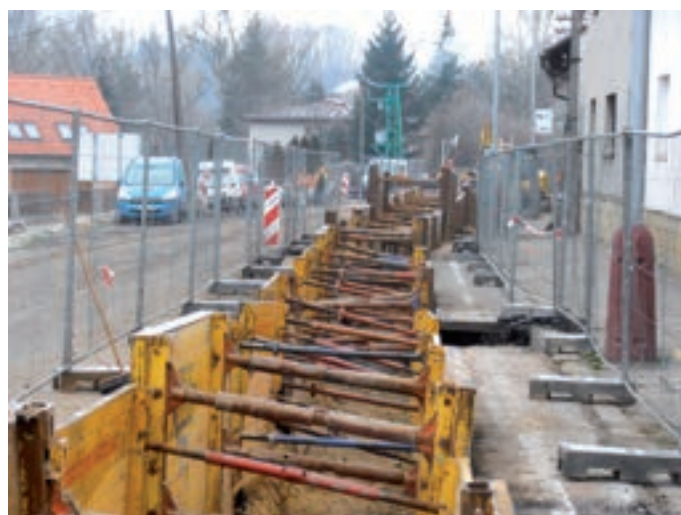
Obr. 8: Vinecká ulice – pokládka kanalizační stoky
