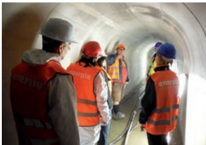
Obr. 10: Mnichovo Hradiště, štola – návštěva zástupců města v průběhu výstavby
