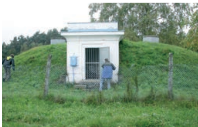
Šetření na jednom ze zemních vodojemů
