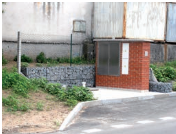
Obr. 7: Bezděčín – čerpací stanice odpadních vod
