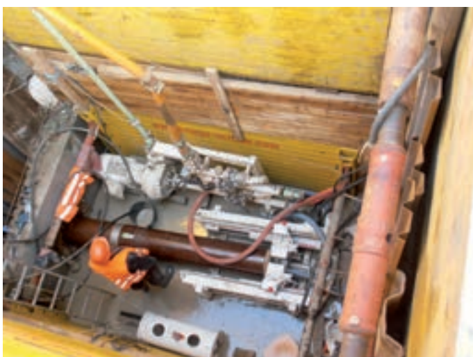
Obr. 6: Chrást – startovací jáma pro bezvýkopovou pokládku kanalizace
