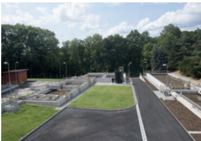
Obr. 9: Mnichovo Hradiště, ČOV – biologický stupeň čištění
