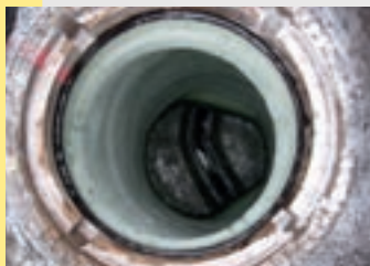
Bezvýkopová obnova revizních šachet metodou VERTILINER
