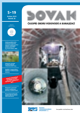
Dno spadiště v ulici Nad Novou Libní
