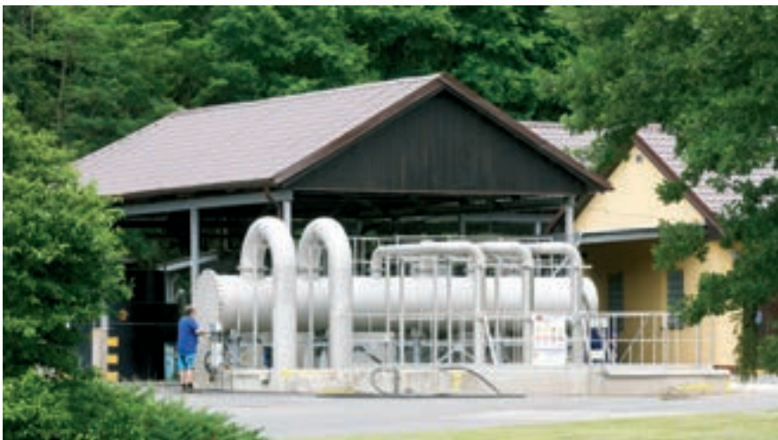
ČOV Beroun – zrekonstruovaná část čerpací stanice a mechanického předčištění
