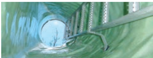
Sanovaná revizní šachta
