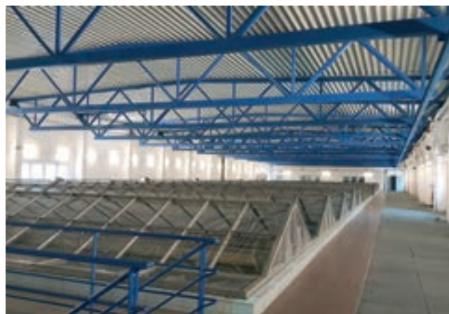
ÚV III – filtrace
