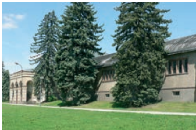
Objekt Chabalovy filtrace
