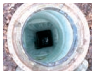
Realizace šachty s čtvercovým profiem
