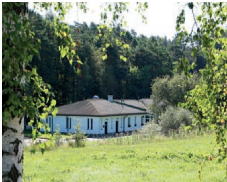
Provozní budova společnosti Voda Červený Kostelec, s. r. o.
