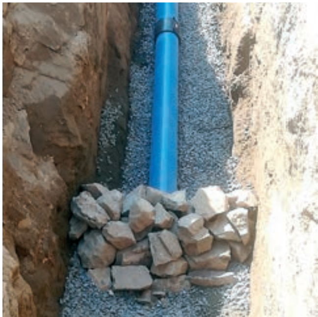
Prameniště Zádub, založení nového jímacího zářezu
