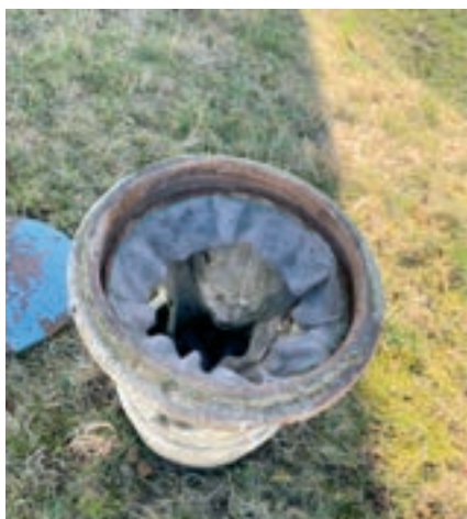
Obr. 2: Vzhled původního stavu filtračních komínů nad akumulací a postup řešení vhodné rekonstrukce
