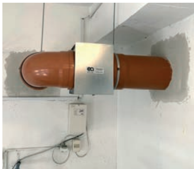
Obr. 3: Vzhled původního stavu přívodu vzduchu do akumulační nádrže a následné nahrazení jiným typem potrubí s umístěnou filtrační vložkou
