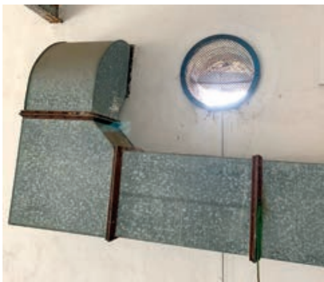
Obr. 3: Vzhled původního stavu přívodu vzduchu do akumulační nádrže a následné nahrazení jiným typem potrubí s umístěnou filtrační vložkou
