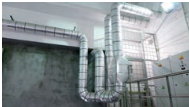
Realizovaný ventilační systém vodojemu, vč. instalace filtračního systému VDJ Klíčov – Praha
