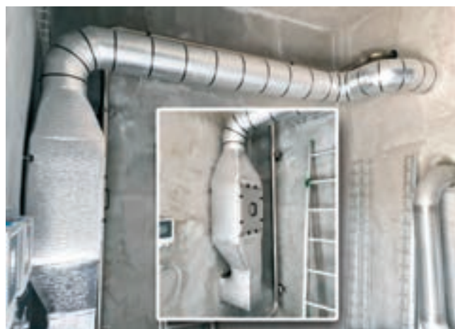
Průběh realizace ventilačního systému vodojemu, vč. instalace filtračního systému VDJ Lysolaje – Praha
