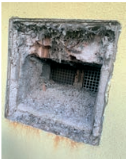
Obr. 1: Postup při zajištění větracích průduchů vložení filtrační vložky a mřížky v manipulačním prostoru přímo nad terénem
