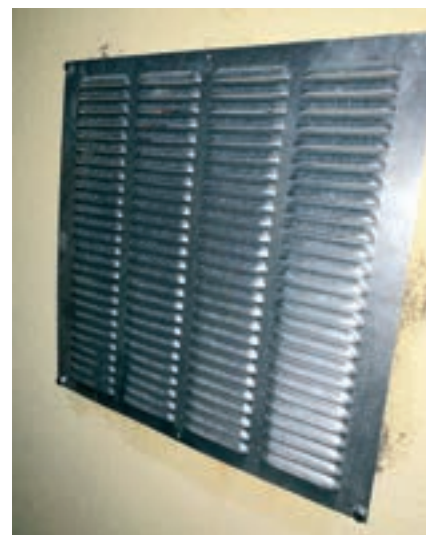
Obr. 1: Postup při zajištění větracích průduchů vložení filtrační vložky a mřížky v manipulačním prostoru přímo nad terénem
