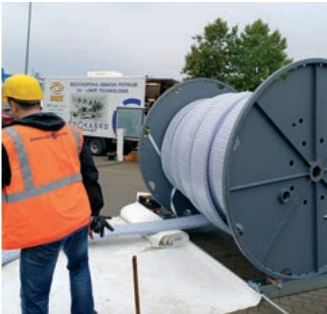
Zatahování vložky PrimusLine DN 500
