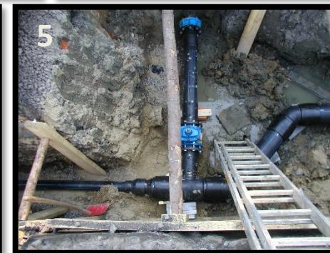
5 – výkop vodovodu z PE
