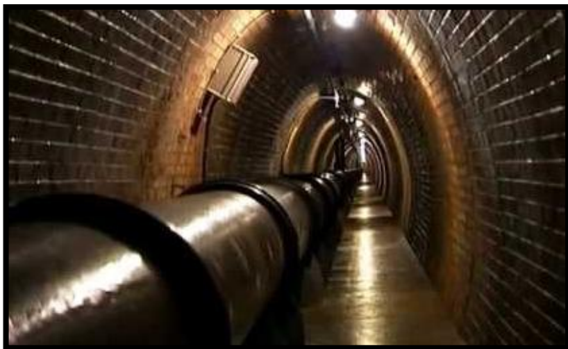
Štola Březovského přivaděče
