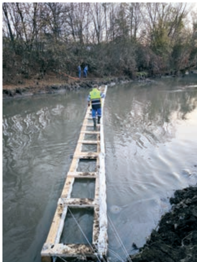
Norná stěna na Černém potoce
