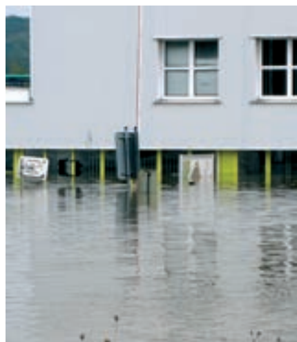
Zaplavený vstup do správní budovy ÚČOV
