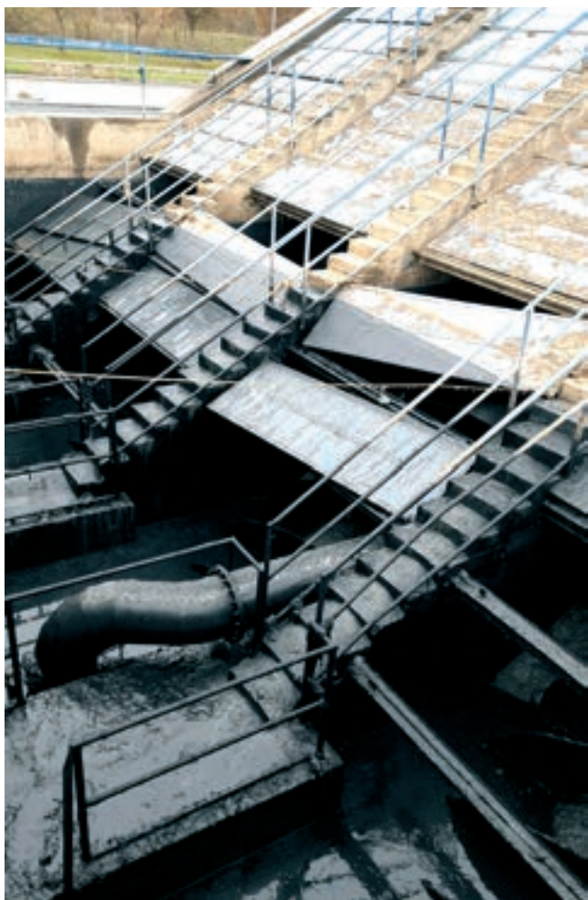
Vstupní čerpací stanice na přivaděči D po opadnutí vody
