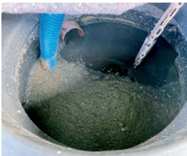
Obr. 1: Testovací místo 2 – pohled na sondu \text{H}_2\text{S} ponořenou do odpadní vody
