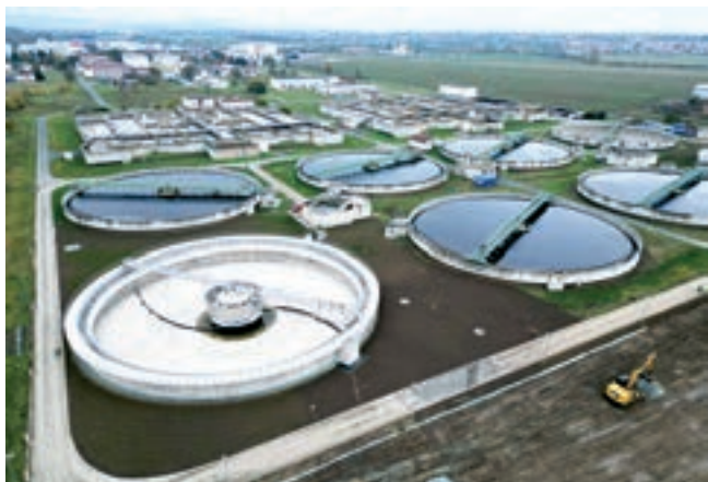
Dosazovací nádrž č. 8 před uvedením do provozu
