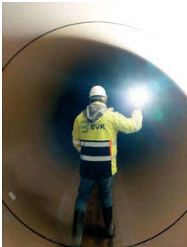
Obr. 5: Nová kmenová stoka C, sklolaminát DN 2 450
