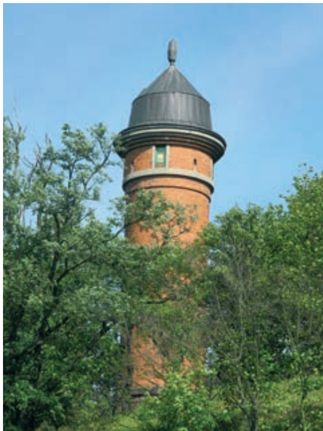
I. březovský vodovod – odlehčovací věž v Letovicích
