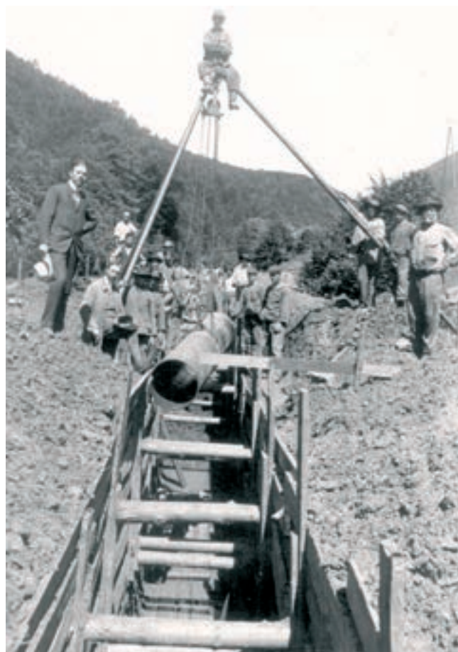
I. březovský vodovod – kladení potrubí na trase přivaděče
