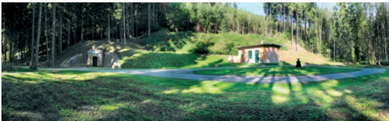
I. březovský vodovod – prameniště
