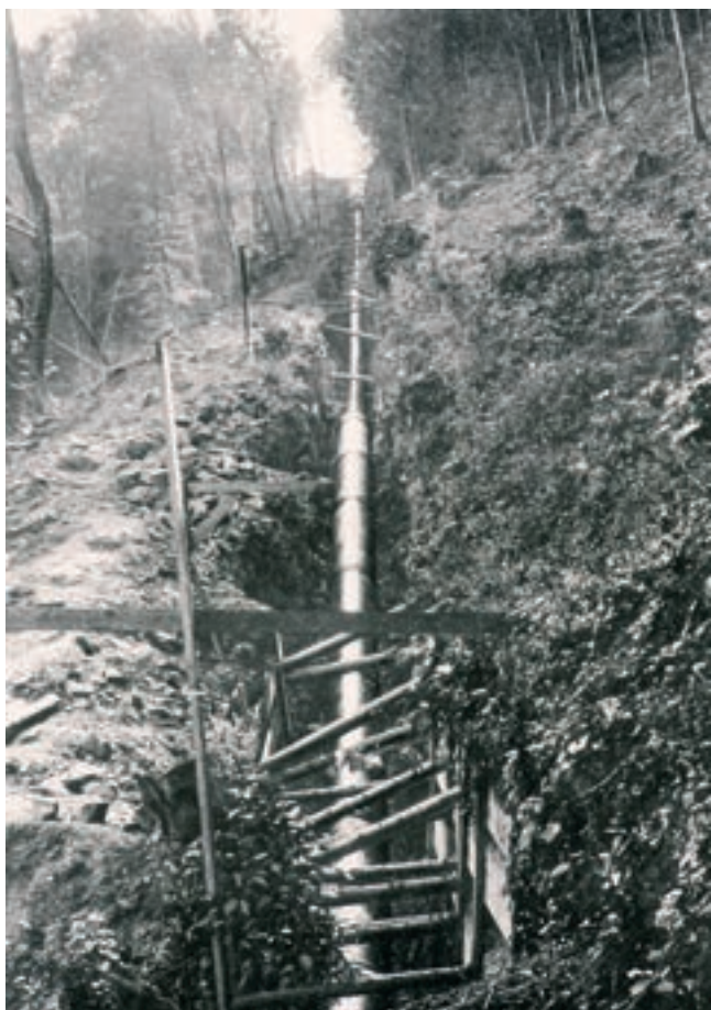
I. březovský vodovod – výkop pro potrubí u kilometru 7.0 v sekci I
