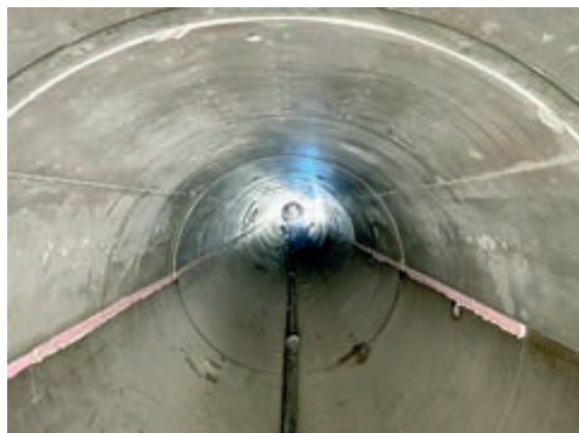
Obr. 4: Kombinace polymerbetonových žlabů DN 2 200 a monolitické klenby, stav těsně před dokončením
