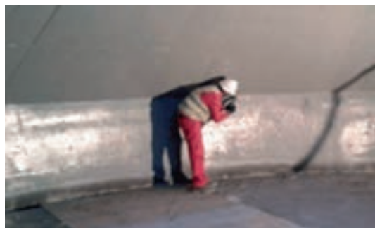
Sikalastic® M 689 ve vyhřívací nádrži v čistírně odpadních vod
