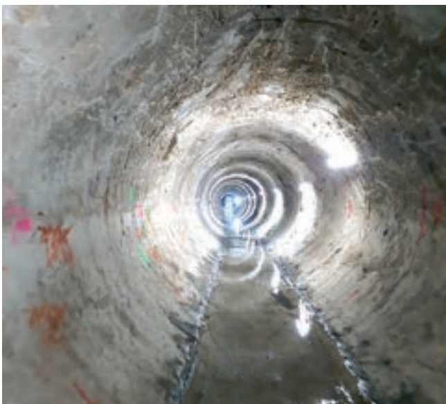
Obr. 2: Stav štoly po vybourání vnitřního obložení
