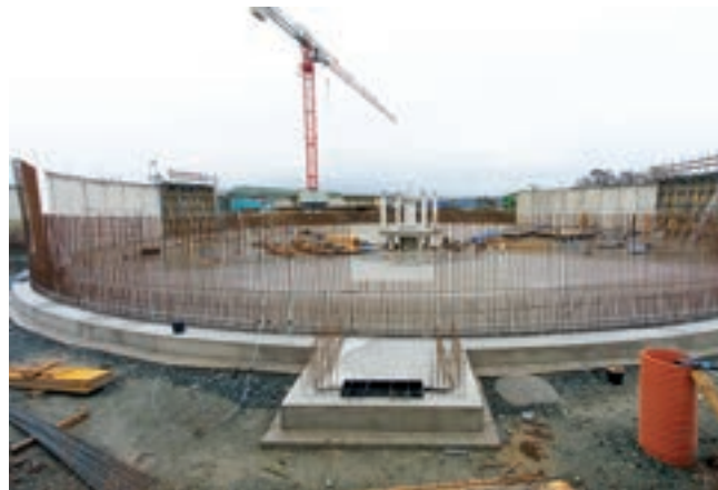
Dosazovací nádrž v průběhu výstavby
