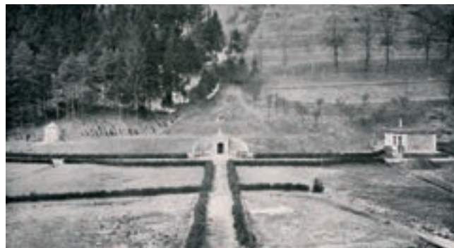
Celkový pohled na prameniště I. březovského vodovodu, 1913
