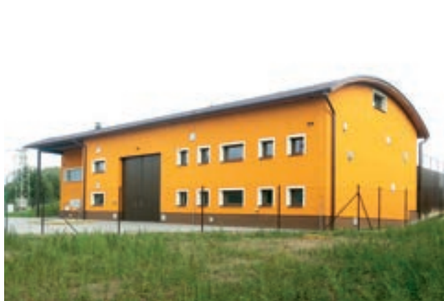
Obr. 3: Úpravna podzemní vody a vodní zdroj Chocně (do provozu uvedena v roce 2016)
