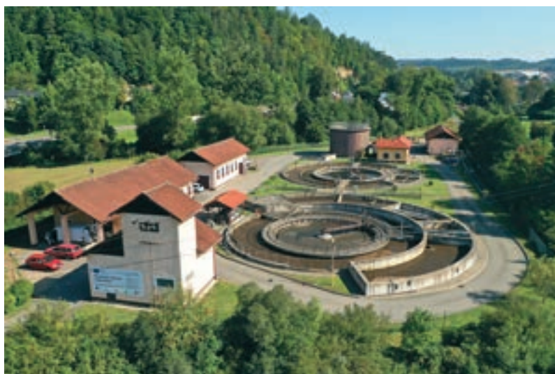
Obr. 1: Čistírna odpadních vod Letohrad (do trvalého provozu uvedena v roce 2015)
