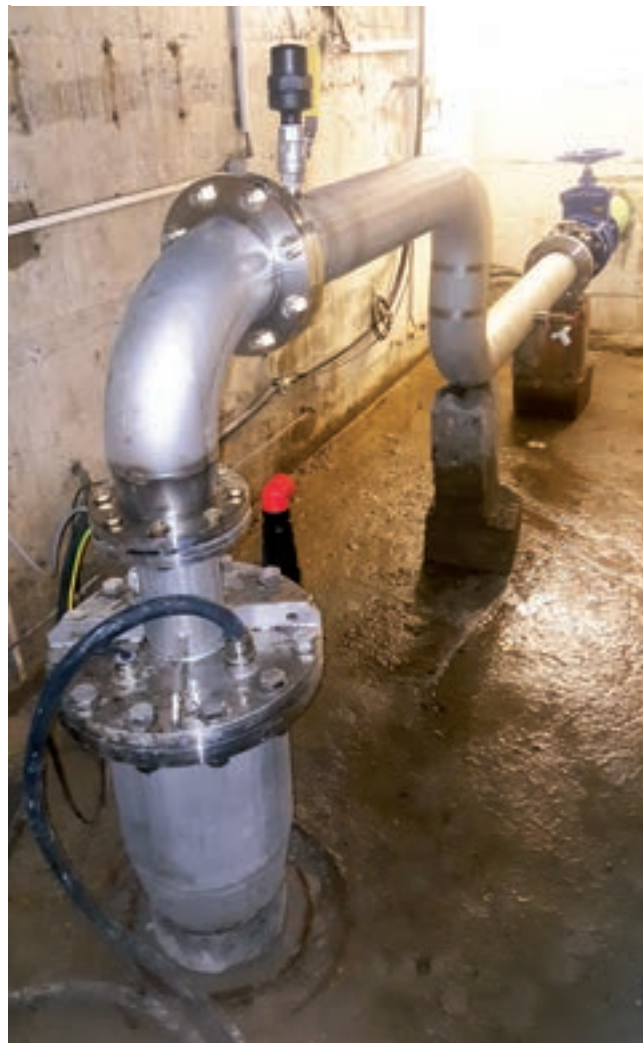
Pohled na zhlaví a výtlak rekonstruovaného vrtu V-3 horní Čermná
