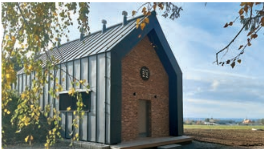
Obr. 2: Vodojem Sudslava s kapacitou akumulace 2 \times 100 \text{ m}^3
