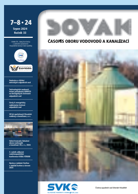
Čistírna odpadních vod Uherské Hradiště
