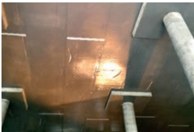
Obr. 2: Použití fólie do stropní desky
