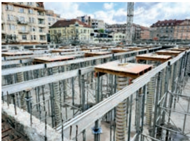
Obr. 1: Demolice stávajících konstrukcí a nahrazení novými konstrukcemi
