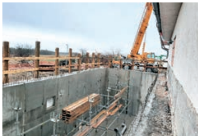
Obr. 3: Přibetonávka po odbednění
