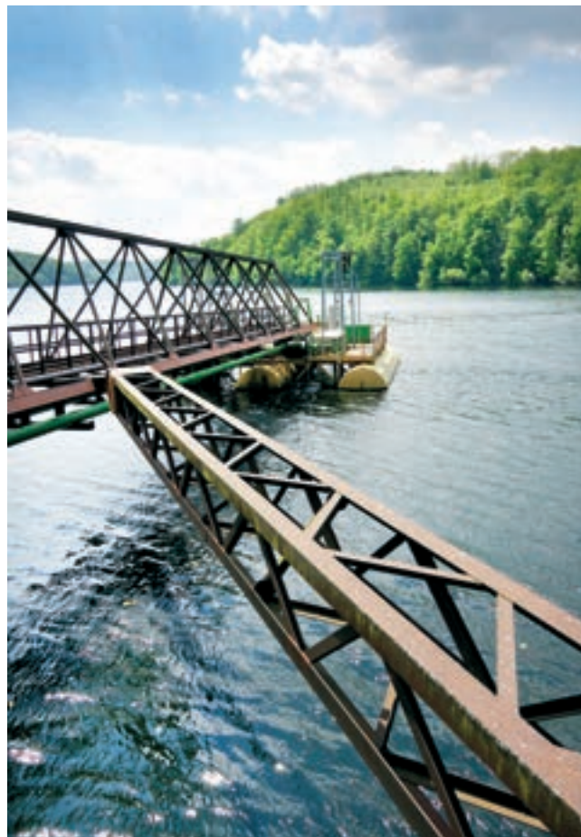
Součástí projektu propojování vodárenských soustav je i návrh na řešení odběru surové vody z vodní nádrže Vranov, který v současné době zajišťuje plovoucí ponton.
