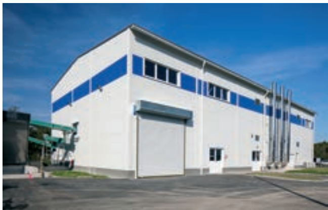
Hala sušárny čistírenských kalů, ČOV Šumperk
