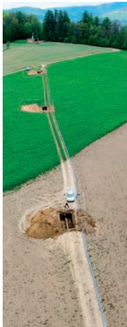
Obnova přivaděče Kouty nad Desnou, montážní jámy pro bezvýkopovou obnovu přivaděče
