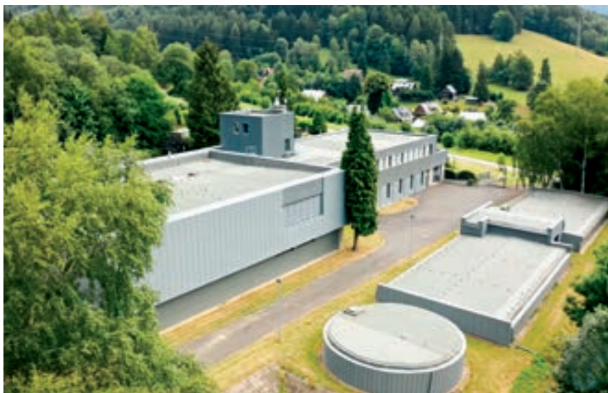
Úpravná vody v Koutech nad Desnou
