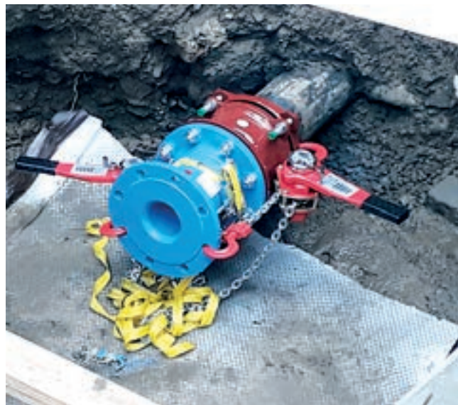
Obr. 6: Přírubový konektor po montáži
