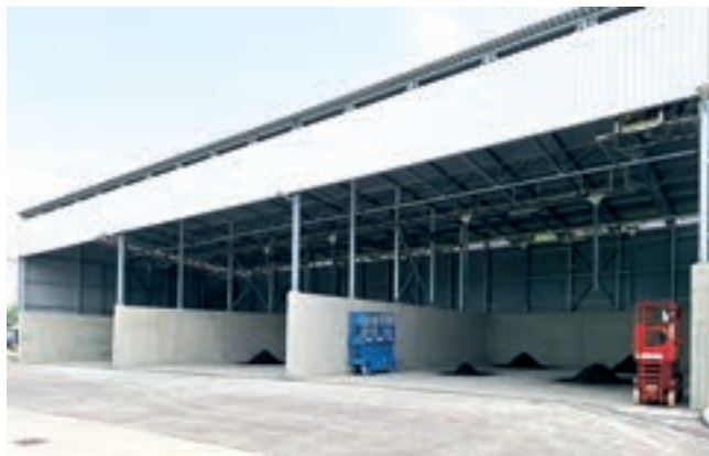
Hala skladování vysušeného kalu, ČOV Šumperk
