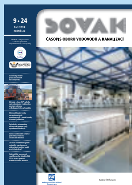
Sušárna ČOV Šumperk
