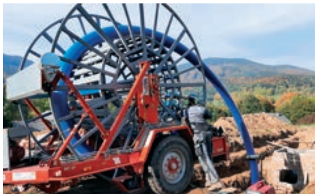
Obnova přivaděče Kouty nad Desnou, zatahování předdeformovaného potrubí
