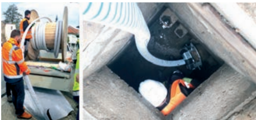
Obr. 3 a 4: Instalace vložky přes stávající armaturní komoru – 100% bezvýkopově
