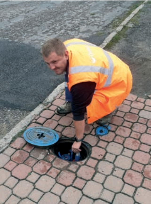
Obr. 2: Osazování loggerů ve Veselí nad Lužnicí
