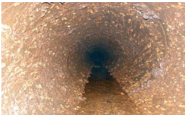
Obr. 2: Ocelové potrubí DN 500 – vnitřní pohled
