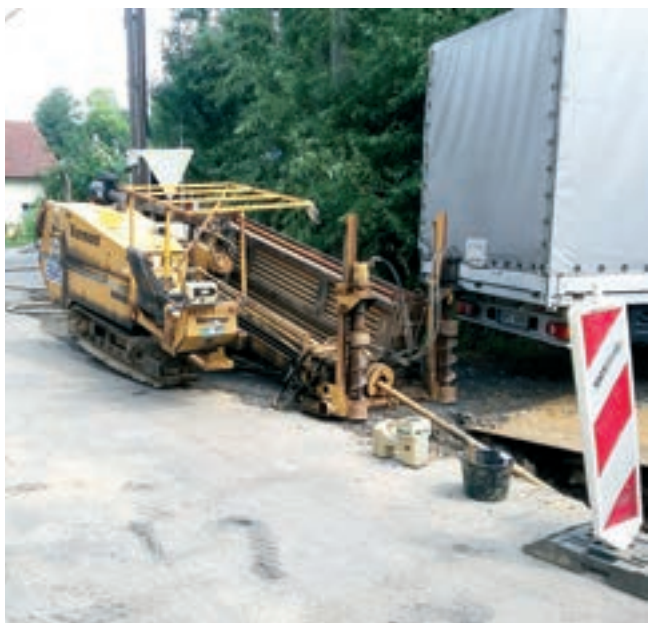
Příklad realizace stavby při použití bezvýkopové technologie – obec Staré Sedliště
