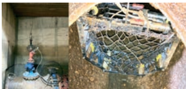
Obr. 5: Sestava pro zachycení nástrojů a usazení extrakční sítě v místě vyjmutí
