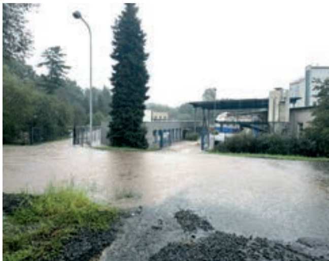
Čistírna odpadních vod Orlová
