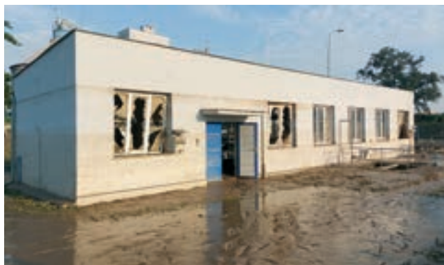
Čistírna odpadních vod Opava
