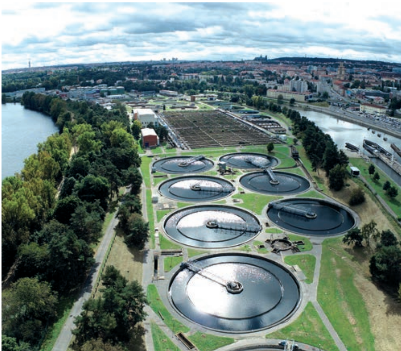
Pražská Ústřední čistírna odpadních vod na Císařském ostrově
