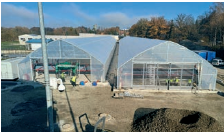
Pro solární sušení kalů byly navrženy dvě skleníkové haly o půdorysu zhruba 10 \times 110 m
