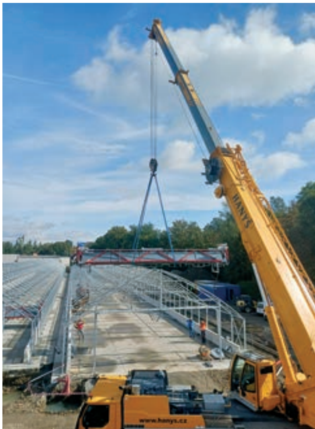
Výstavba solární sušárny kalů ČOV Mariánské Lázně
