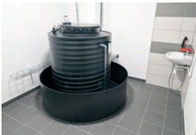
Obr. 2: Zásobní nádrž vyrobeného produktu NaClO v ÚV Nebanice
