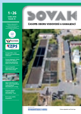
Čistírna odpadních vod Česká Lípa
