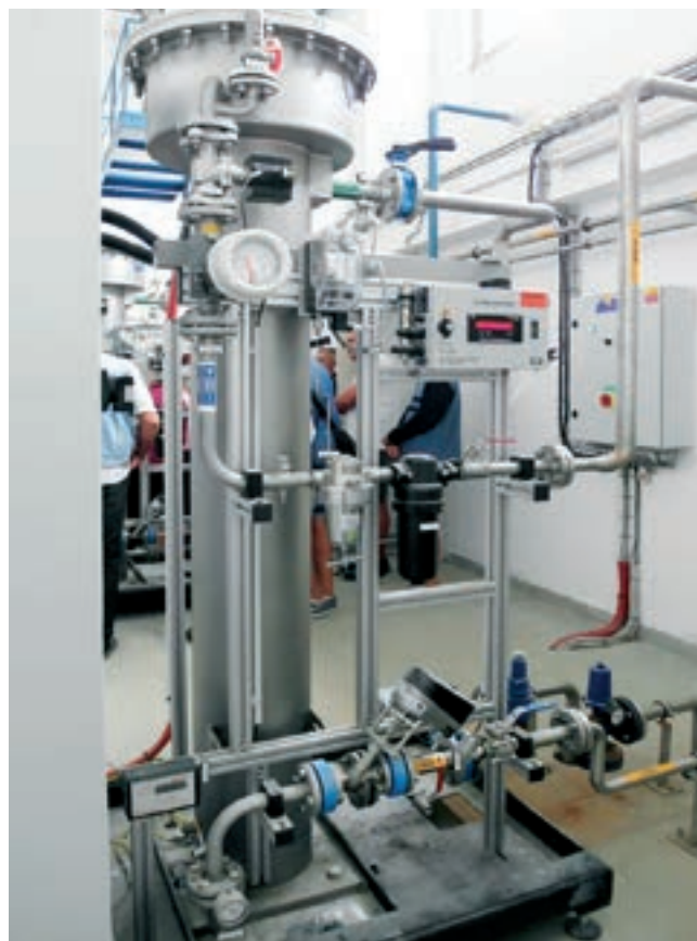
Obr. 4: Generátor ozonu řady WEDECO SMOevo 410
