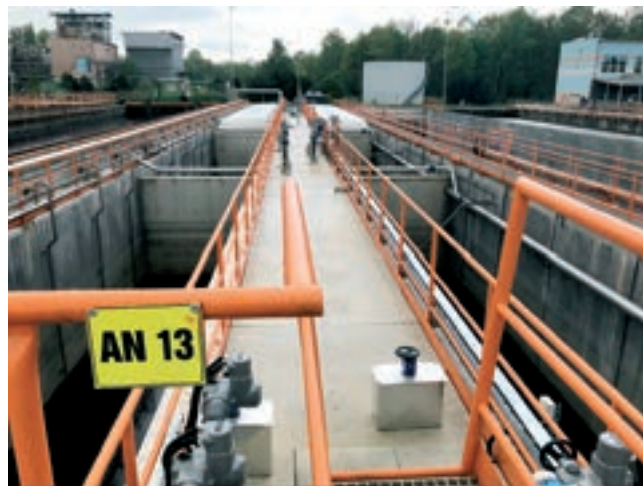
Obr. 5: Pohled na zmodernizovanou nádrž AN13 – čtyři reaktory pro čištění odpadních vod s vysokým obsahem amoniakálního dusíku
