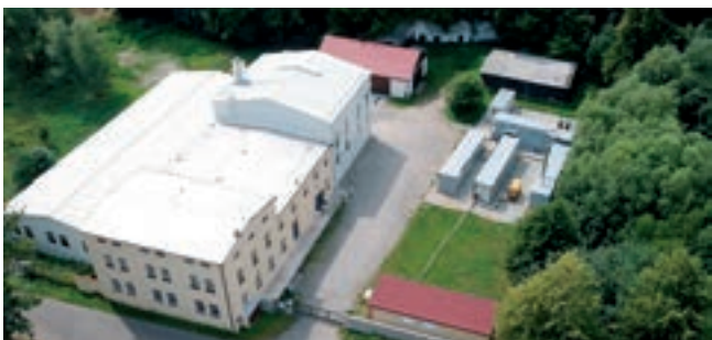
Vědecko-technický park v Dubé u České Lípy. Zde vyvíjí Millenium Technologies technologii plazmového zplyňování
