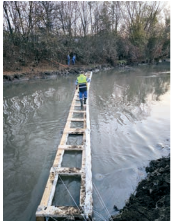
Norná stěna na Černém potoce
