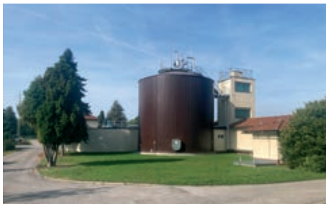
Obr. 6: ČOV Turnov – nová vyhřívací nádrž, 2022
