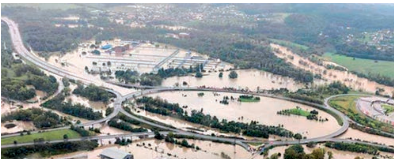
Zaplavená Ostrava-Prívov s dálnicí a s ÚČOV v pozadí
