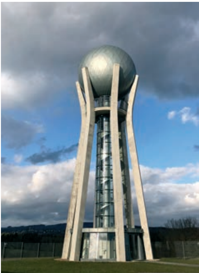
Obr. 2: VDJ Ohrazenice, 2019. Stavba je přístupná vždy v rámci Dne otevřených dveří, které SčVK a VHS Turnov pořádají a dozvíte se o nich na stránkách www.scvk.cz , nebo po předchozí e-mailové domluvě na adrese info@scvk.cz .
