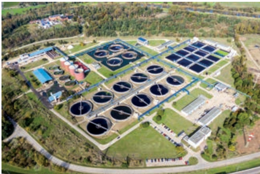
Letecký snímek ÚČOV z října 2024 se stále zaplaveným okolím usazovacích nádrží
