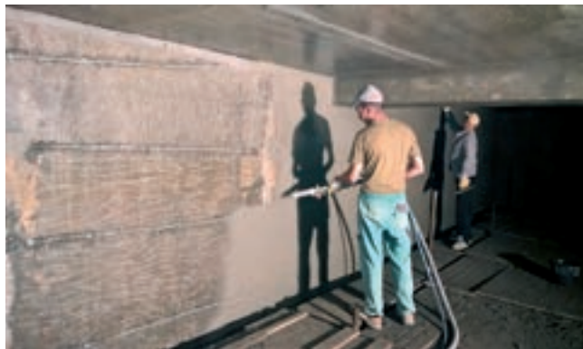
Obr. 5: VDJ Turnov-Károvsko – aplikace Vandexu stříkáním, 2013
