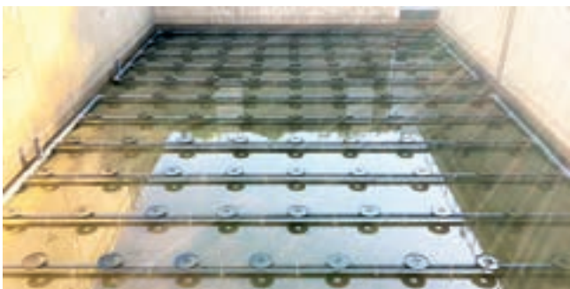
Nový systém provzdušnění na ČOV Chrudim
