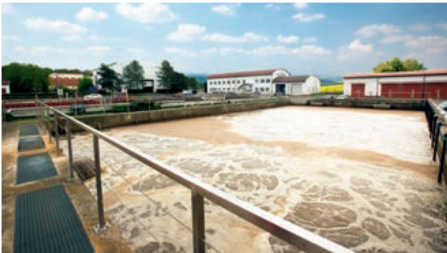
Čistírna odpadních vod Chrudim
