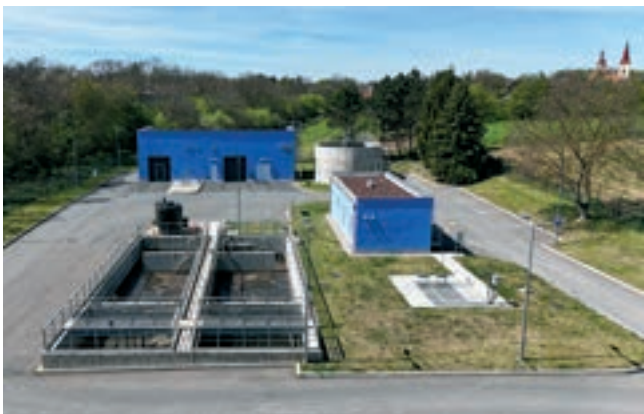
ČOV Mělnické Vtelno – vodohospodářská stavba roku 2025
