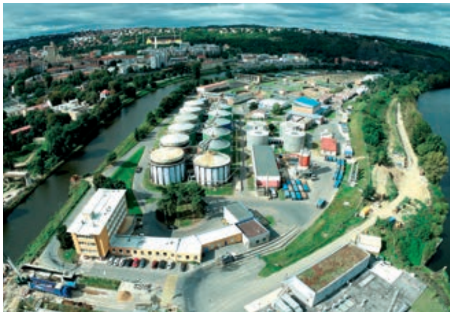
Stávající vodní linka a kalové hospodářství před rekonstrukcí
