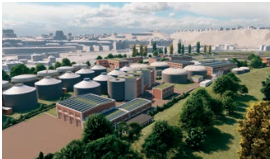
Kalové a energetické hospodářství po rekonstrukci
