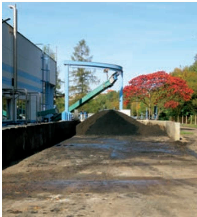
Původní skládka kalů
