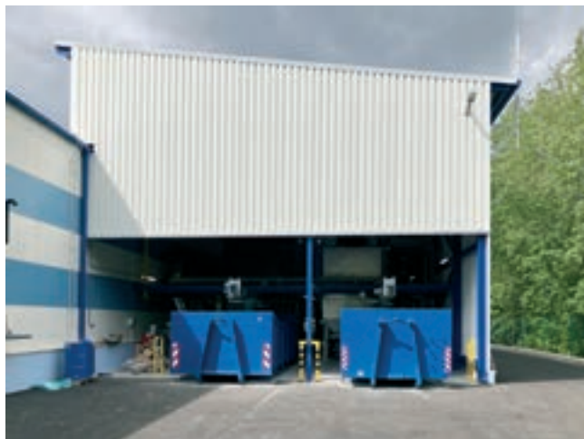
Přístřešek pyrolyzéru s výpadem karbocharu
