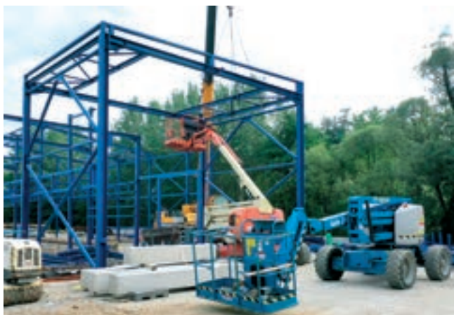
Konstrukce a hotová hala sušárny
