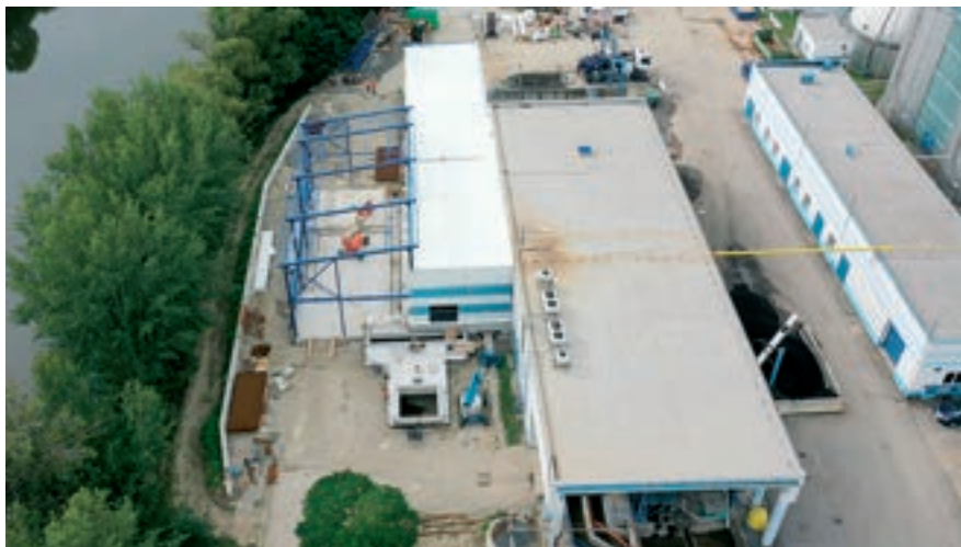
Objekty kalového bunkru, hala sušárny a přístřešek pro pyrolyzér
