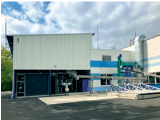
Přístřešek pyrolyzéru, v popředí zhlaví kalového bunkru a dopravníky
