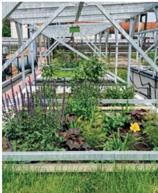
Demonstrační jednotka zavlažování městské zeleně (trávník, květiny, okrasné keře) recyklovanou odpadní vodou na ÚČOV Praha v červnu 2021
