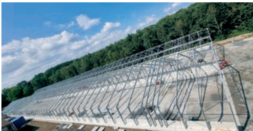
Obr. 3: Pohled na konstrukci hal
