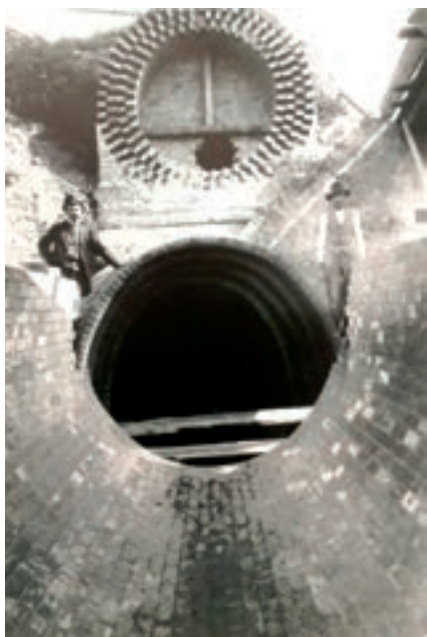
Stavba přívodní stoky do čistící stanice v Bubenči v roce 1901
