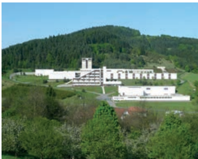
Úpravna vody Švařec
