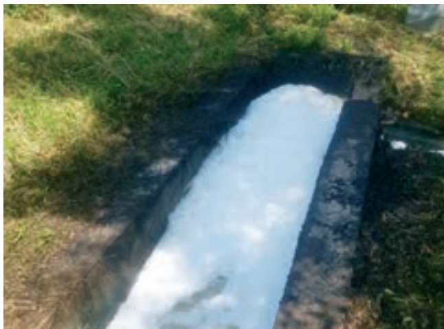
Pění na odtoku čistěných odpadních vod
