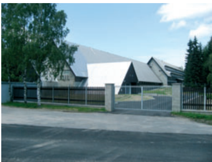
Obr. 1: Jižní pohled na ÚV Souš
