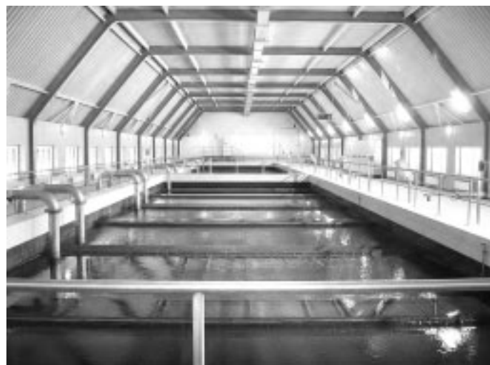
Obr. 2: Rekonstruovaná hala filtrů
