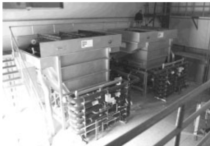
Obr. 6: Flotační jednotky
