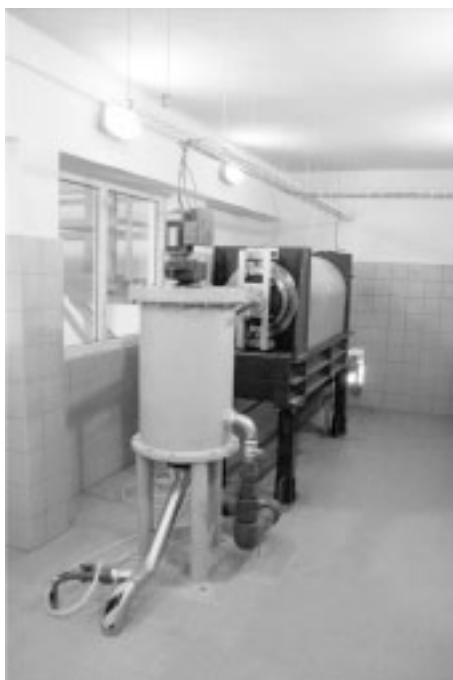
Obr. 7: Šnekový lis s flokulátorem
