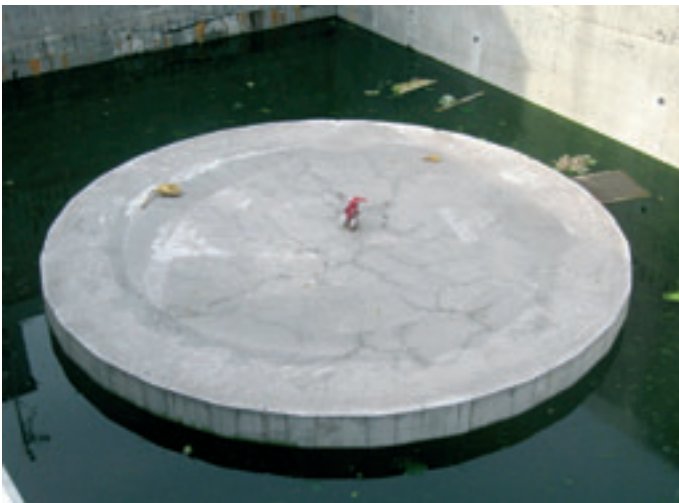
Obr. 9: Položení základu DOSA
