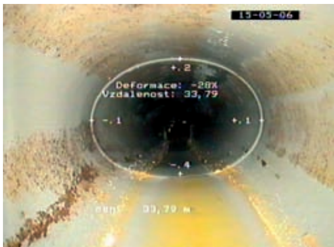
Foto 1: Ovalita uložených plastových trub (fotoarchiv divize Žďár n. S. VAS, a. s.)
