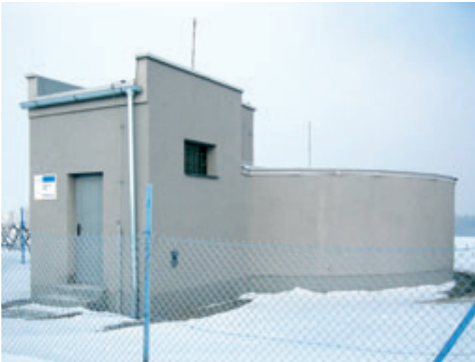
Obr. 3: Celkový pohled na vodojem po sanaci
