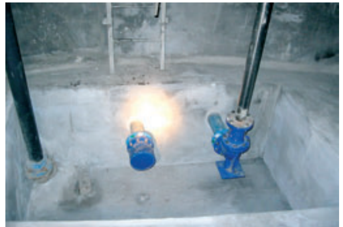
Obr. 5: Vnitřní část akumulční nádrže po sanaci a výměně potrubí
