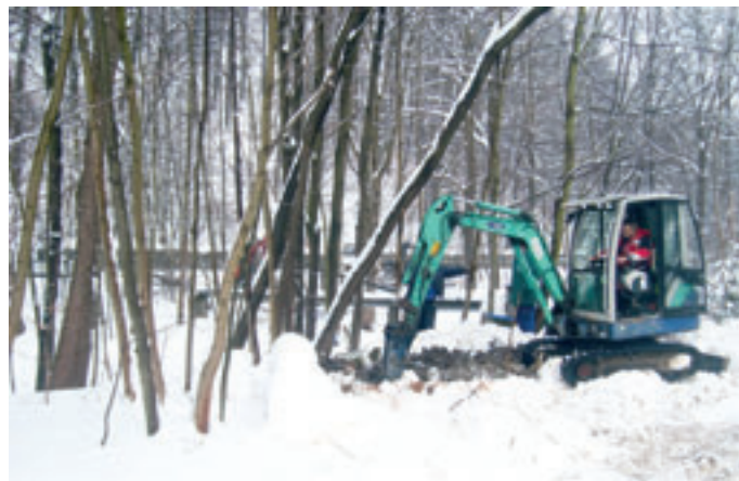
Obr. 4: Výkopové práce při opravě potrubí ocel DN 100 (Hukvaldy)
