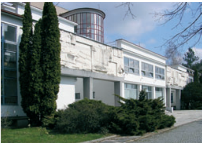
Obr. 1: Úpravna vody v Podhradí u Vítkova
