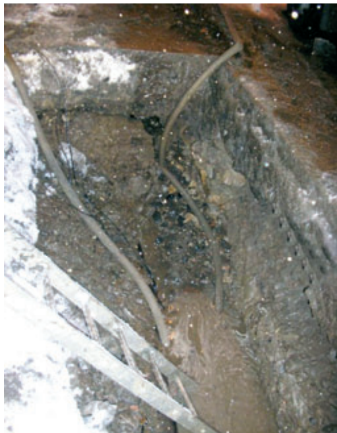
Obr. 3: Ztížené zimní podmínky při odstraňování poruch (Příbor, ul. Místecká, potrubí DN 300)
