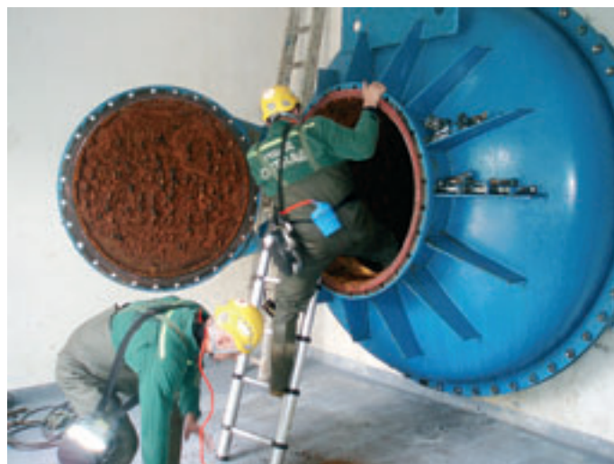
Obr. 3: Vstup pracovníků HBZS do horního „vstupního“ objektu vodárenské štolý na Podhradí
