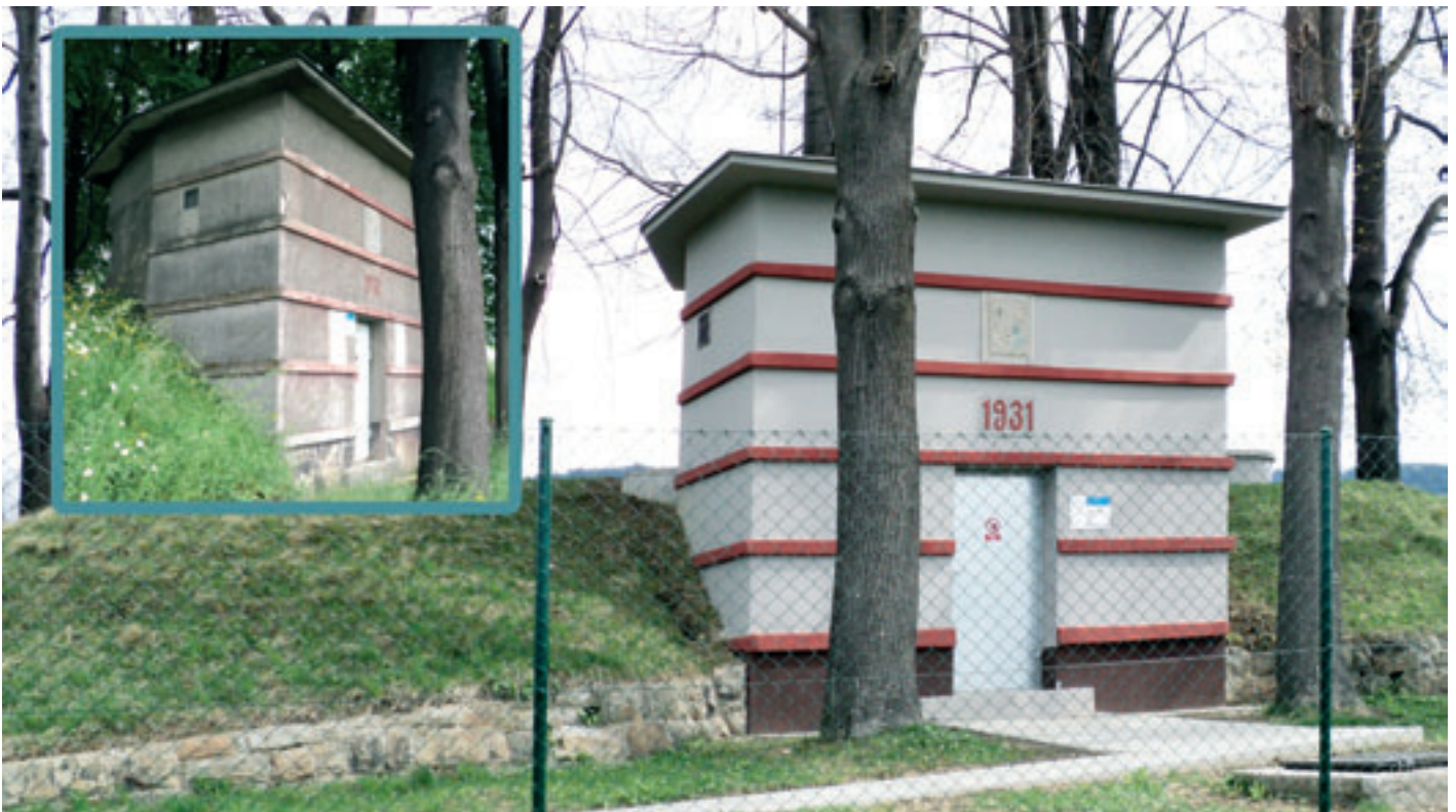
Obr. 6: Stav vodojemu po opravě. Pohled na vodojem před opravou ve výřezu
