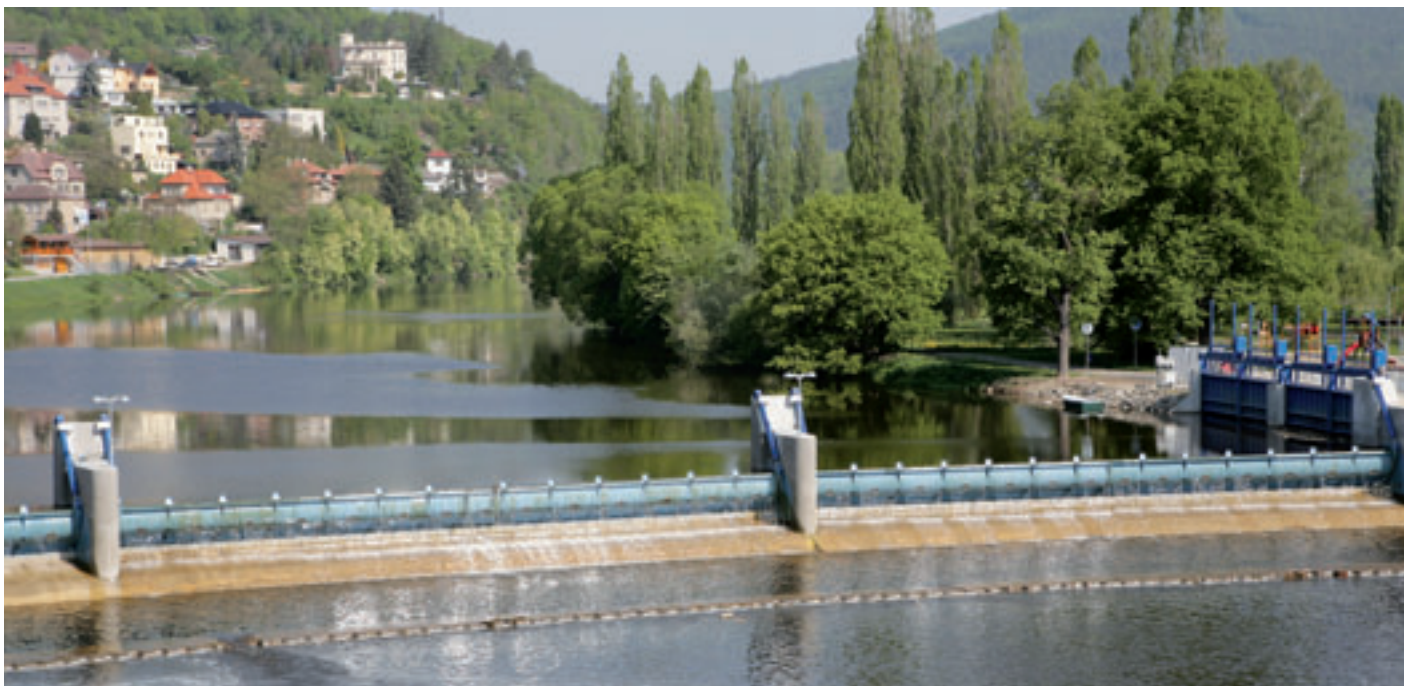
Malá vodní elektrárna, jez a rybi přechod Beroun
