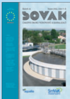
Titulní strana: Rekonstruovaná část ČOV Nový Jičín, Severomoravské vodovody a kanalizace Ostrava, a. s.
