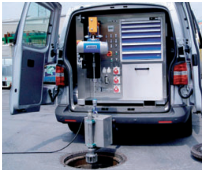
Obr. 2: Kompaktní MRT Systém přímo na stavbě
