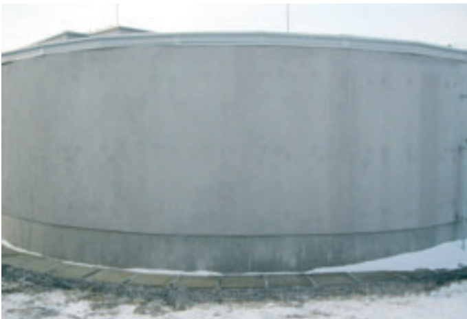
Obr. 4: Stav fasády akumulční nádrže po sanaci
