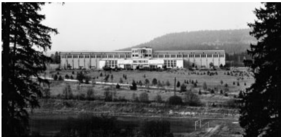
Historický pohled na úpravnu vody Podhradí
