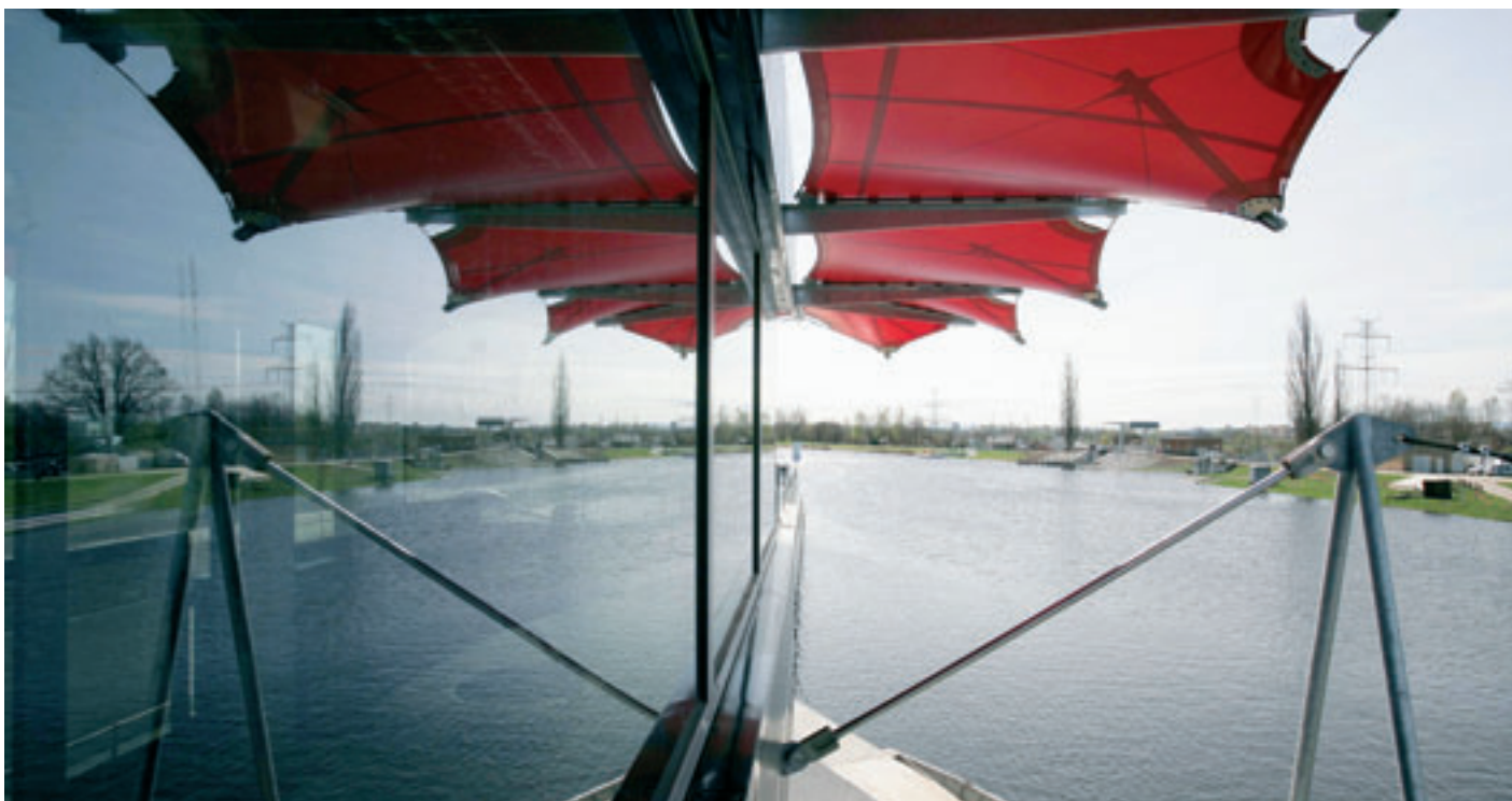
Plavební komora České Vrbné včetně horní a dolní rejdů
