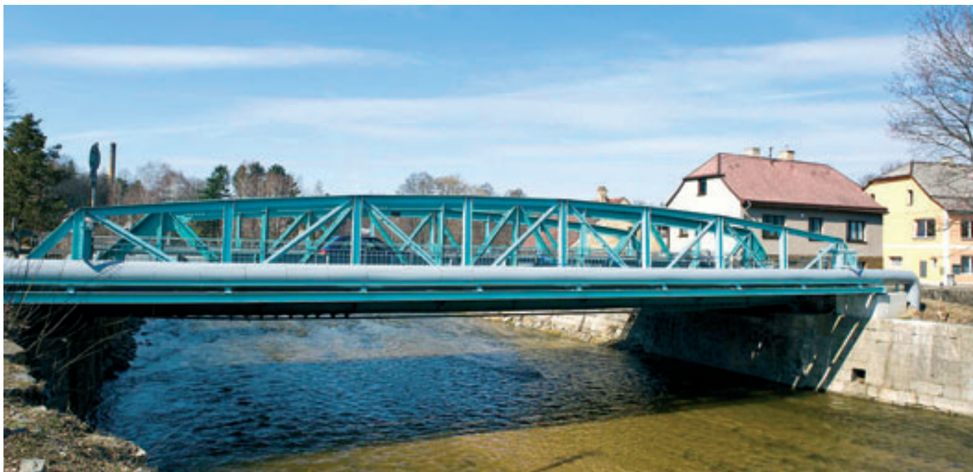
Frydlant – odstranění povodňových škod, Sdružené trubní přemostění Směd
