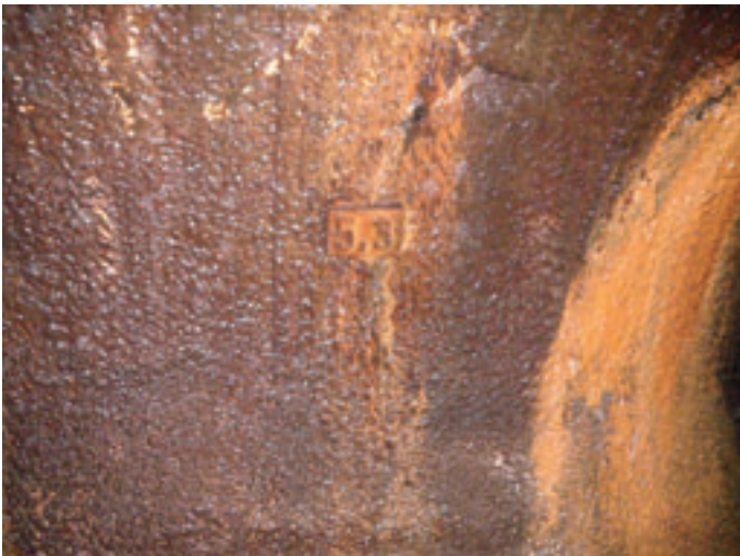
Obr. 5: Obezdvíky štolý provedené torkretováním – staničení 5,300 m
