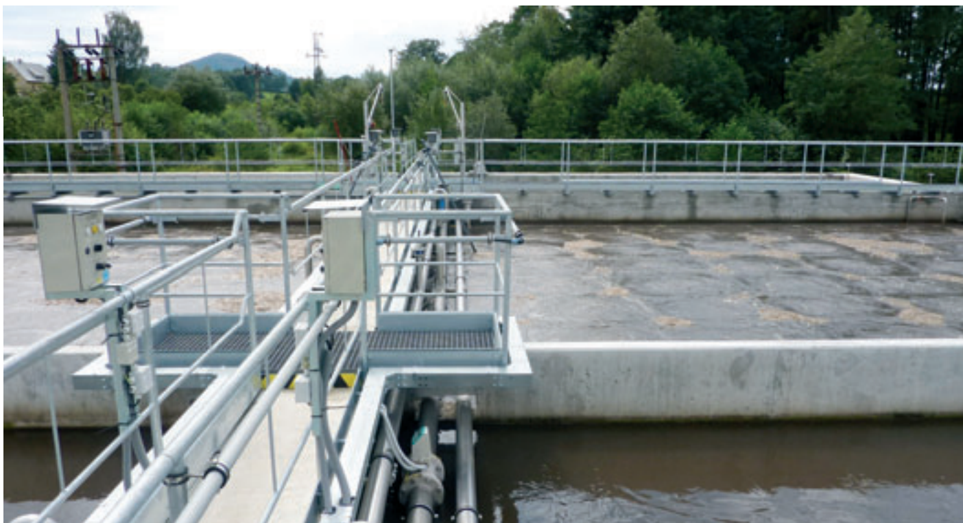
Jablouné v Podještědí – rekonstrukce ČOV
