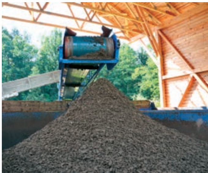
Odvodnění kal v kalové koncovce
