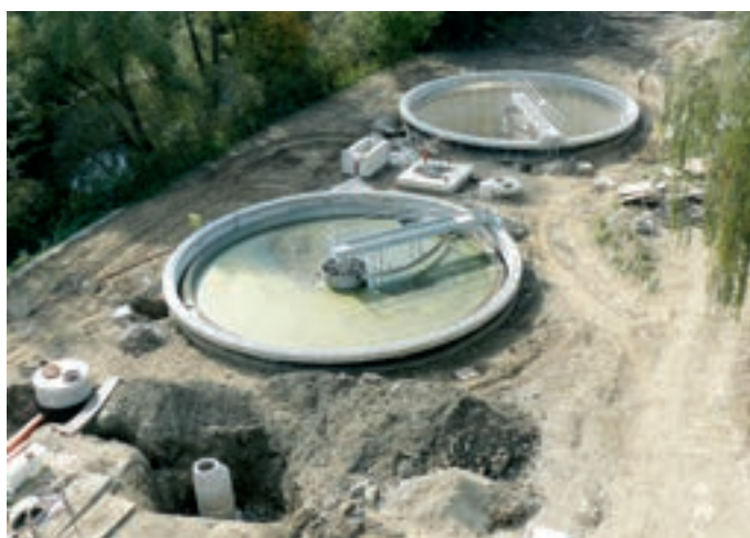
Kruhové dosazovací nádrže po instalaci technologie
