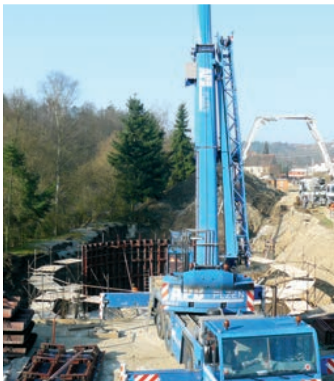
Montáž kruhového bednění stěn
