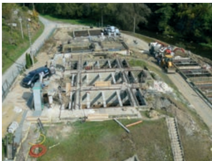
Rekonstrukce nádrží na regeneraci a denitrifikaci
