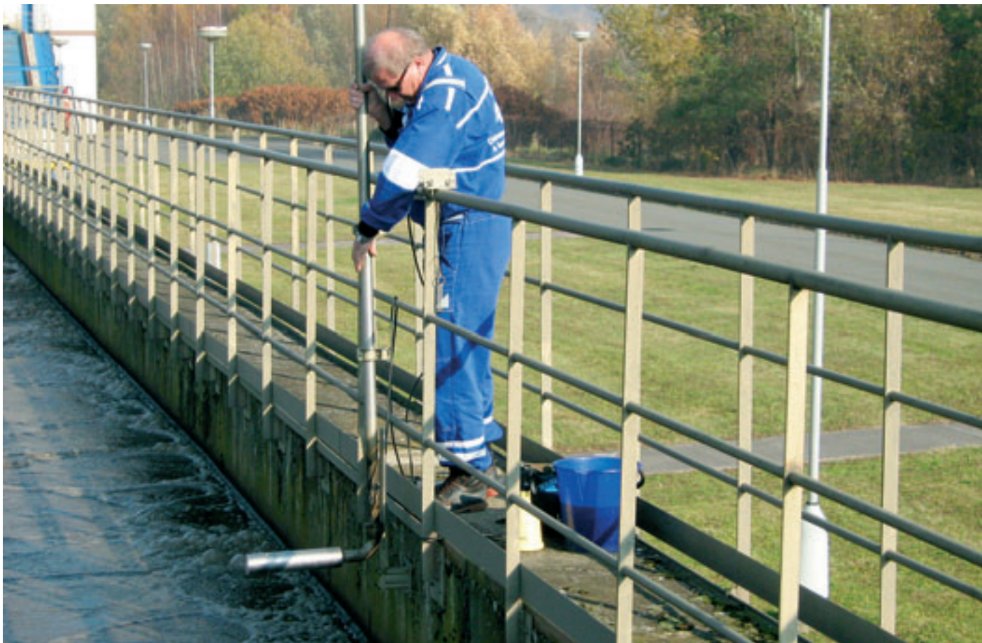
Obr. 1: Umístění sondy v aktivační nádrži
