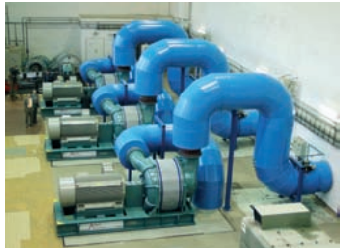
Obr. 2: ÚČOV Praha – dmychárna č. 2 – původní radiální jednokolové turbokompresory typ 1RLS-88 a nová vícestupňová odstředivá dmychadla GardnerDenver 2400
