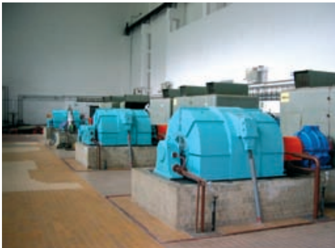
Obr. 2: ÚČOV Praha – dmychárna č. 2 – původní radiální jednokolové turbokompresory typ 1RLS-88 a nová vícestupňová odstředivá dmychadla GardnerDenver 2400
