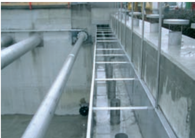
Obr. 5: Řešení odtahu kalu z konce DN
