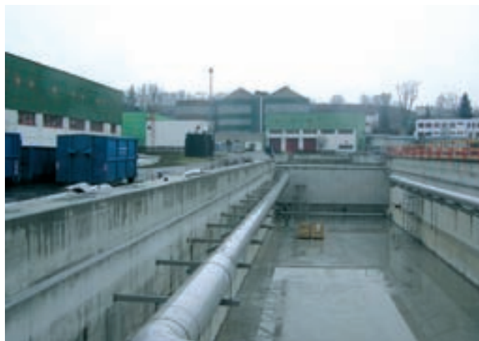
Obr. 6: Odsazené odtokové potrubí z DN
