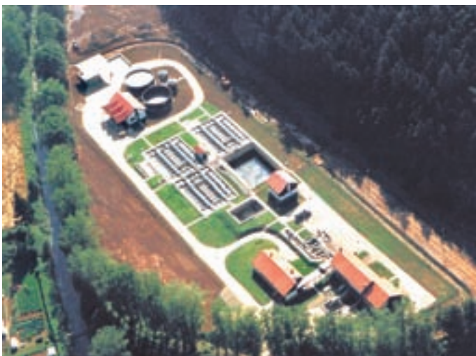
ČOV Moravská Třebová
