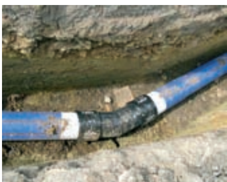
Obr. 11: Lom v trase přívaděže, oblouk 45°
