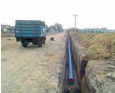
Obr. 9: Výkop – přívaděcí řad SO 02 – lokalita před dálnicí D 11
