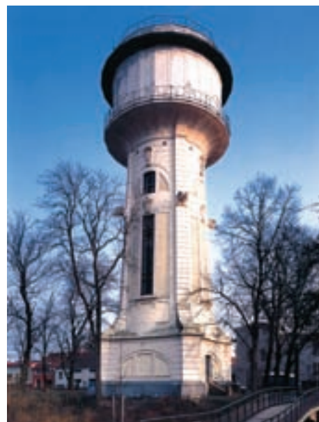
Věžový vodojem v Nymburku (ukázka z knihy)
