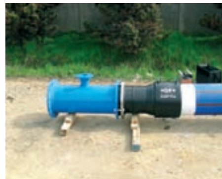
Obr. 10: Připojení vzdušníku na potrubí d 355 – redukce 355/315, navařovací příruba
