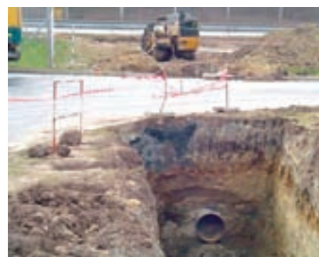
Obr. 13: Protlak pod dálnicí D 11 a místní komunikací v areálu průmyslové zóny
