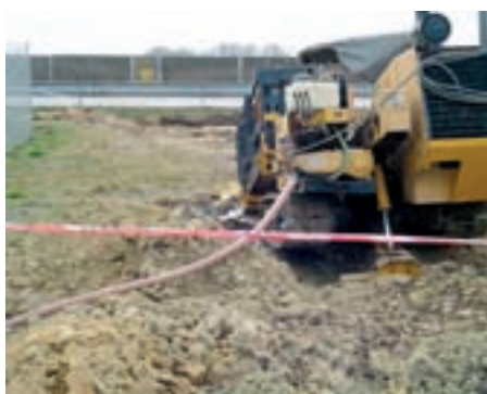
Obr. 12: Protlak pod dálnicí D 11 – Jirny, vrtná souprava
