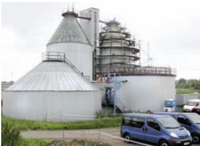
Vyhňivací nádrž 1 v rekonstrukci
