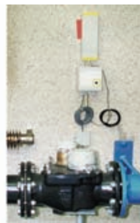
Obr. 4: Na jednom vodoměru svazu napojený zásobník dat DL220 W s anténou v horní krabici
