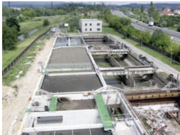
Zprovoznění levé linky biologického stupně a rekonstrukce pravé linky
