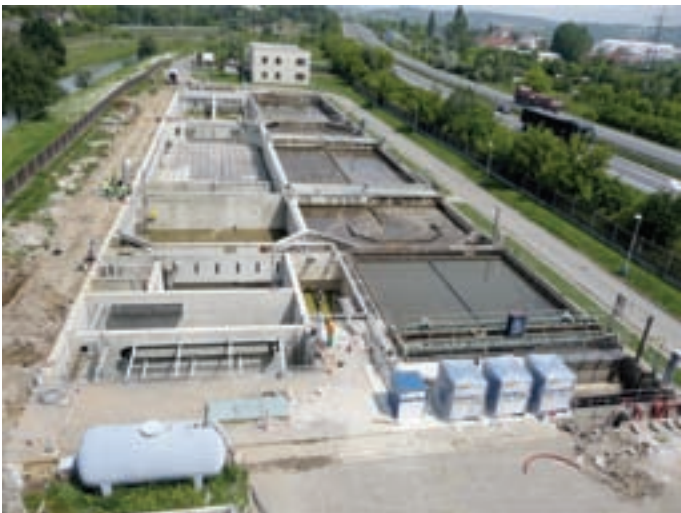
Rekonstrukce levé linky biologického stupně
