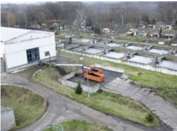
Pohled na biologickou linku před rekonstrukcí
