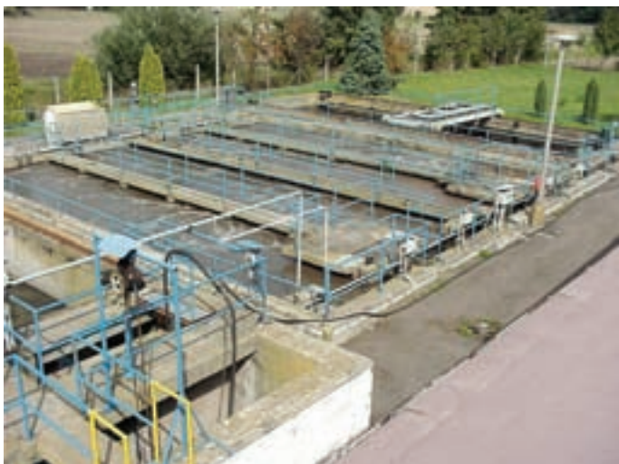
Pohled na původní biologickou část ČOV ...
