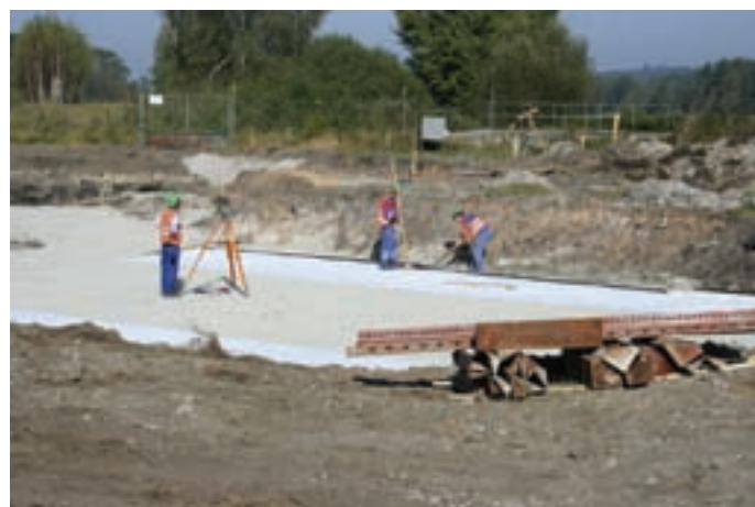
Čistá Ploučnice: ČOV Doksy (foto po zahájení stavby)
