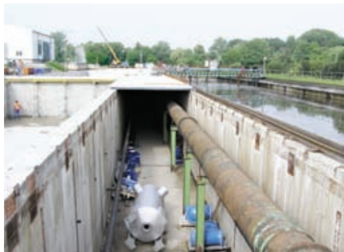
Rekonstrukce aktivční nádrže a kolektoru
