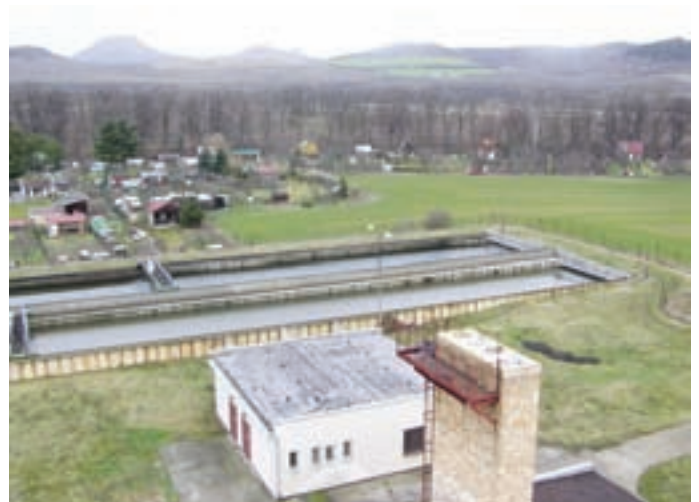
Pohled na biologickou linku před rekonstrukcí
