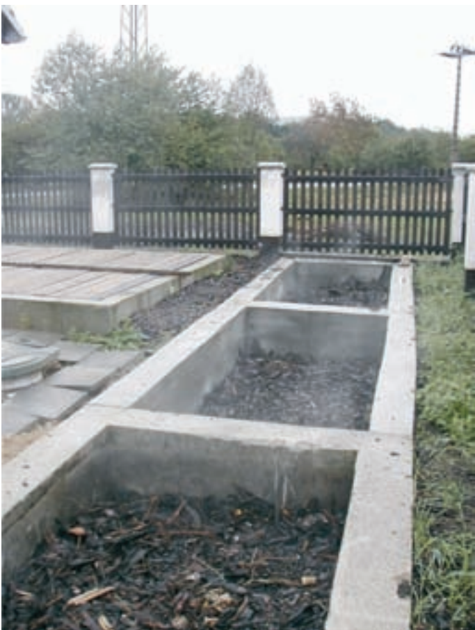
Obr. 4.4: Pohled na biofiltr pro podtlakovou stanici
