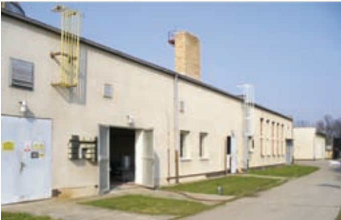
Strojovna kalového hospodářství před rekonstrukcí
