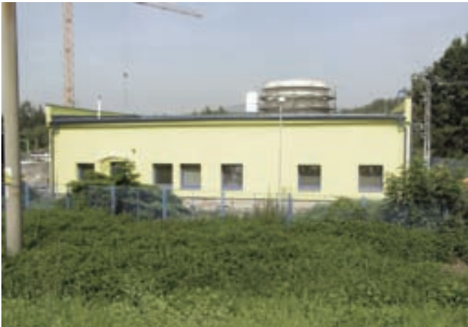
Provozní objekt po rekonstrukci
