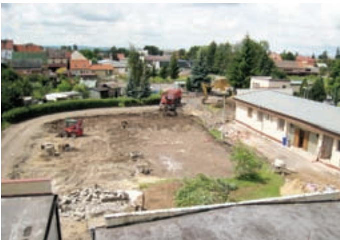
Zrušená kalová pole
