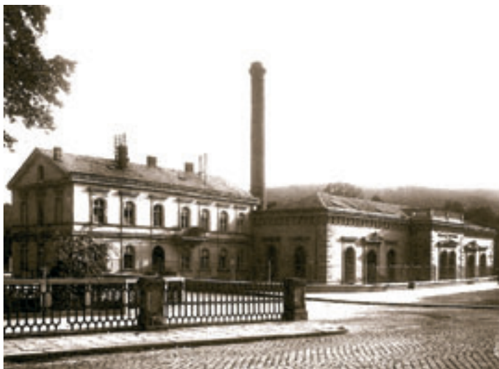
Budova vodárny v Pisárkách v roce 1872
