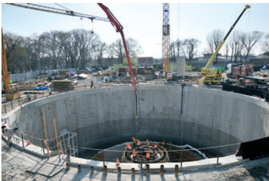
Obr. 2: Výstavba retenční nádrže Jeneweina
