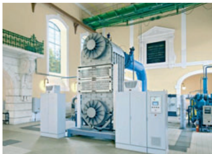
Obr. 2: 1. stupeň UV systému DUV-36/120, max. průtok 5 000 m 3 /h na výtlačky čerpadel 2. stupně
