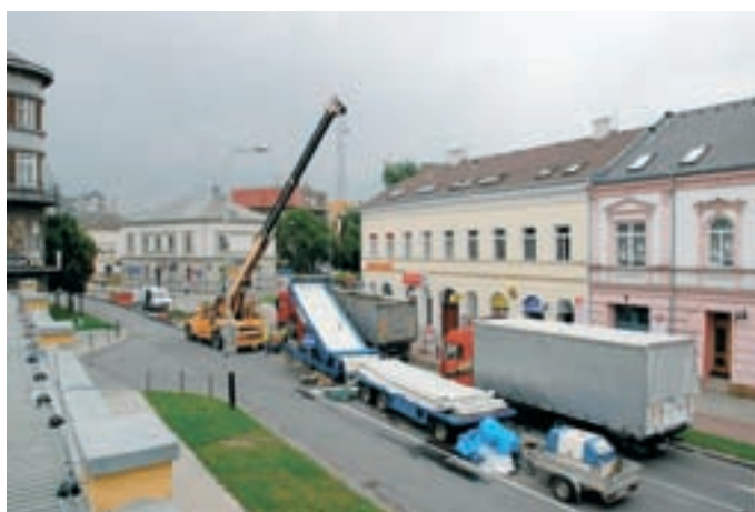
Přerov – instalace vložky do sběrače A (DN 1200/1800) na ulici Komenského při minimálním omezení dopravy
