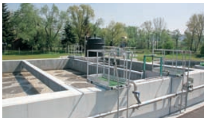
Třetí sekce aktivačních nádrží a chemické srážení fosforu
