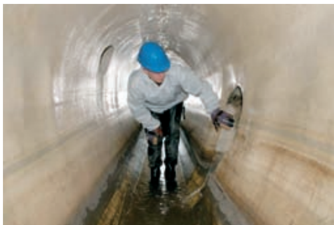
Přerov – dokončená vložka KAWO ve sběrači, DN 1200/1800 v Přerově – Komenského ulici
