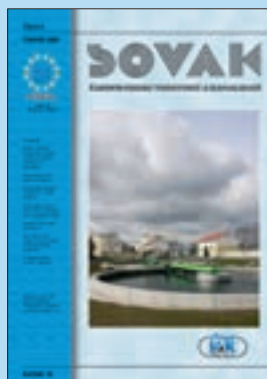
Titulní strana: Rekonstruovaná ČOV Lipník nad Bečvou. Vlastník a provozovatel: Vodovody a kanalizace Přerov, a. s.
