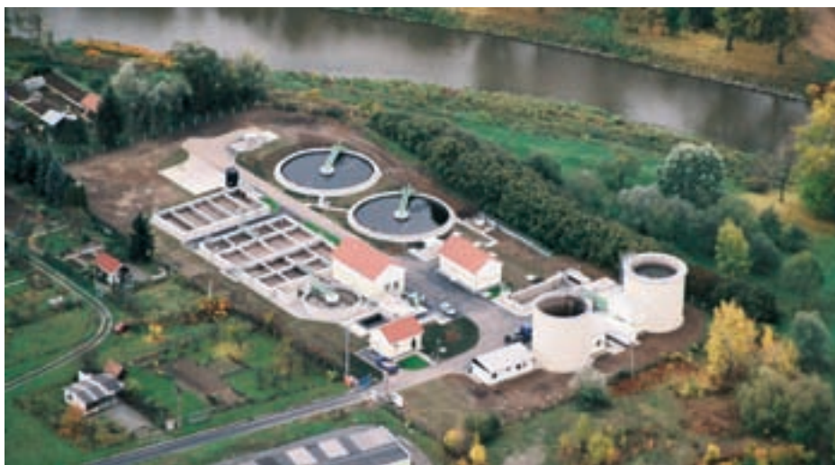
Letecký snímek ČOV Lipník Lipník nad Bečvou
