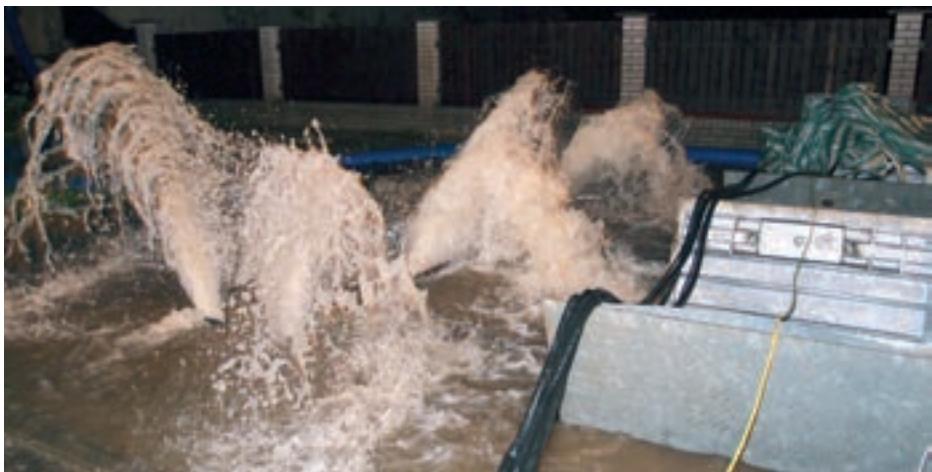
Obr. 4: Netěsnosti na jedné z komor – Zbraslav
