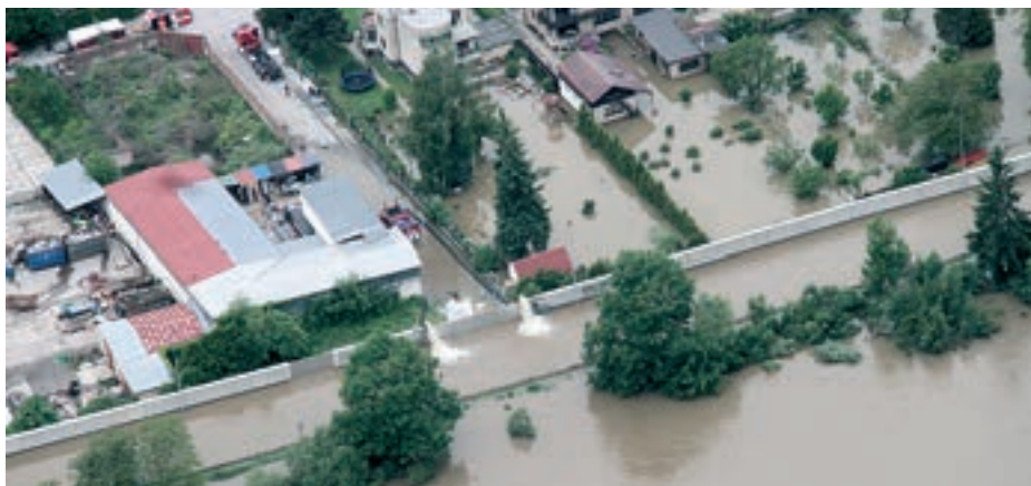
Obr. 6: Situace se zatopením části ochráněného území Zbraslavi po instalaci čerpadla HZS (Q 1 500 l/s)
