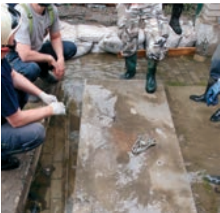
Obr. 5: Kontrola tlakového montážního poklopu po odpnutí vody
