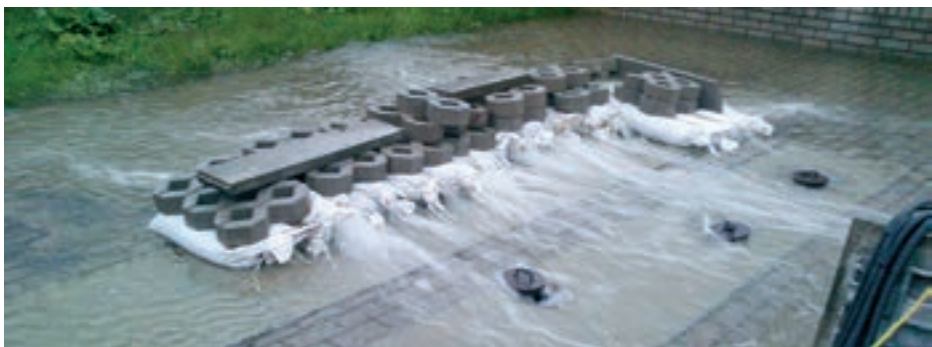
Obr. 3: Netěsnosti na jedné z komor – Zbraslav
