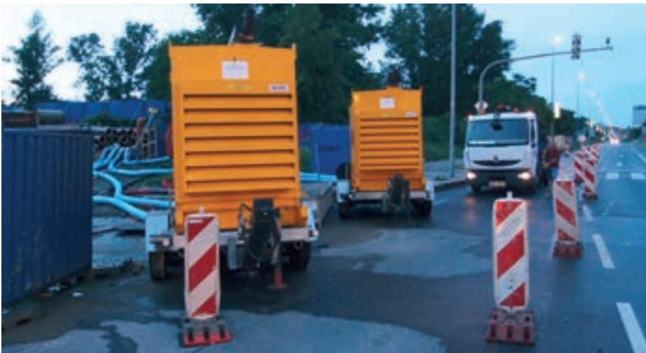
Obr. 2: Mobilní čerpací technika v ul. Pobřežní – čerpání B před Karlínskou shybkou do proplachovacího kanálu, čerpadla 2× 200 l/s
