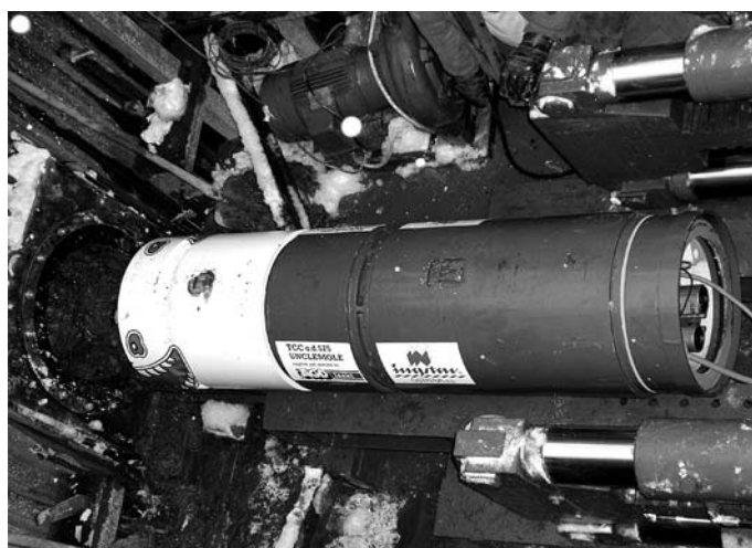
Obr. 4: Mikrotunelovací stroj TCC Unclemole Iseki osazený ve startovací šachtě (Ingstav Ostrava, a. s.)
