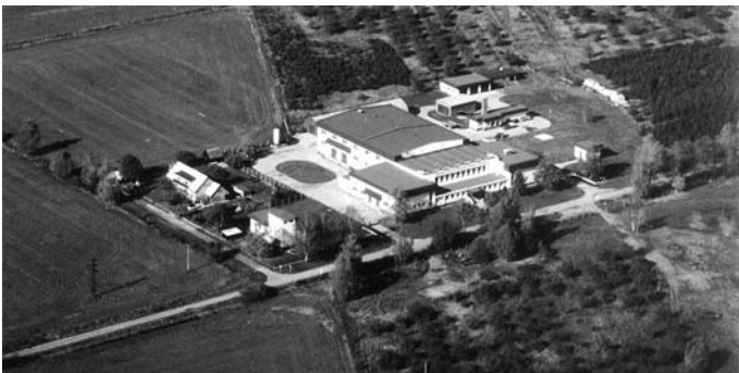
Úpravná vody Hrobice
