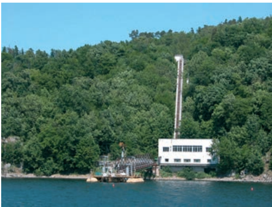
Obr. 1: Čerpací stanice na plovoucím pontonu v Jelení zátoce
