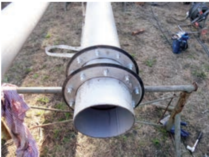
Obr. 4: Průběh a výsledek rekonstrukce havarovaného vodárenského vrtu
