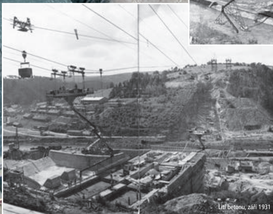
Betonování dna vývařiče
