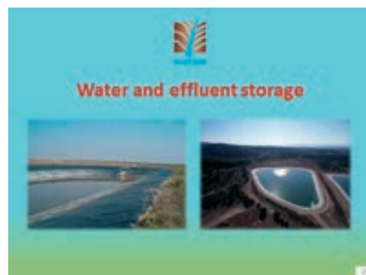
Obr. 7: Ukázka akumulčních nádrží pro soustředění vyčištěných odpadních vod k následnému využití pro závlahy v zemědělství. (Zdroj – prezentace Meytal Shen-Zur, Praha, 2014)
