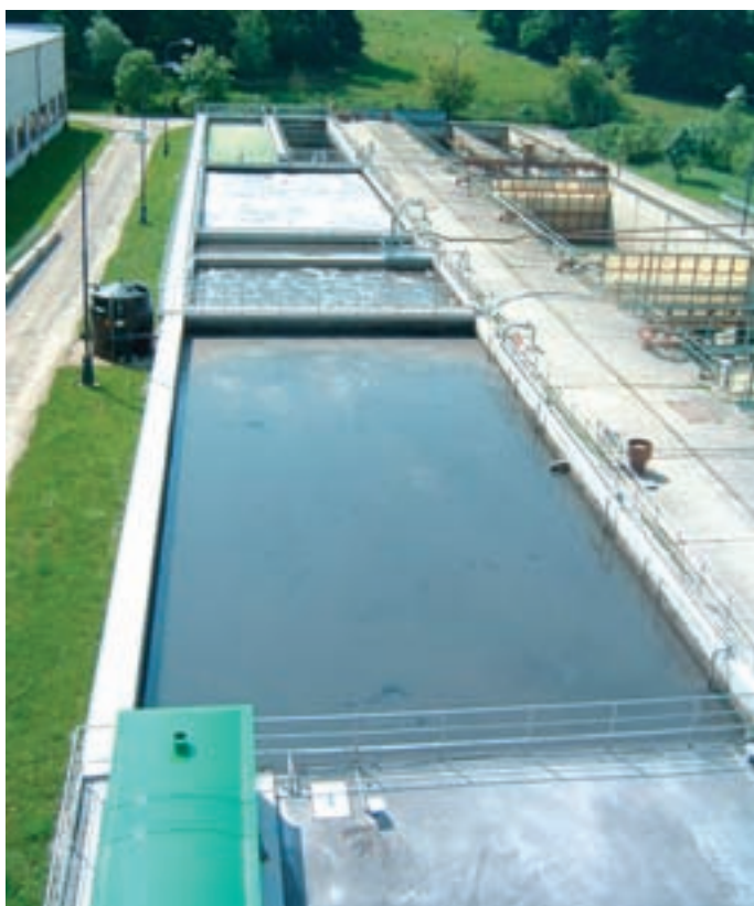
Pohled na aerobní linku 2: je fotografována z vrcholu IC reaktoru a znázorňuje postupně zdola nahoru zásobní nádrž přebytečného kalu, regeneraci, denitrifikaci, nitrifikaci a dosazovací nádrže
