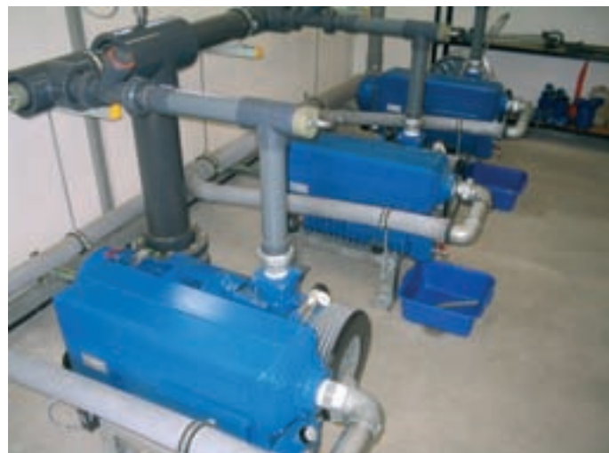
Obr. 2: Vývěvy systému podtlakové kanalizace Prostějov-Bedihošť jsou umístěny v samostatné provozní budově
