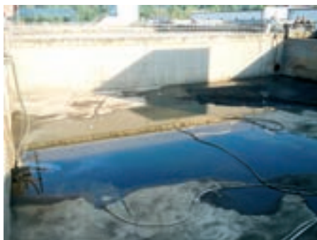
Obr. 9: Vyčištěná denitrifikace
