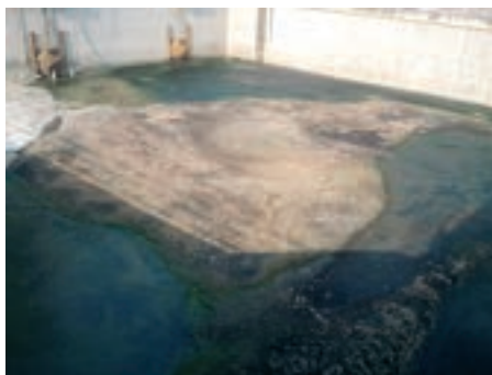
Obr. 6: Vypuštěná denitrifikace
