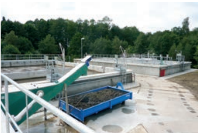
Jablonné v Podještědí – rekonstrukce ČOV. Stavba byla oceněna v roce 2011 v soutěži Vodohospodářská stavba roku
