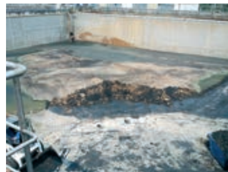
Obr. 7: Výška vrstvy kalu v denitrifikaci
