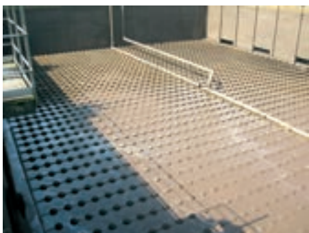
Obr. 2: Vypuštěná aktivace
