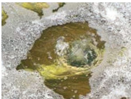
Obr. 12: Chybně upevněná membrána
