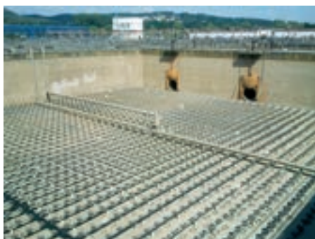
Obr. 3: Vyčištěná aktivace
