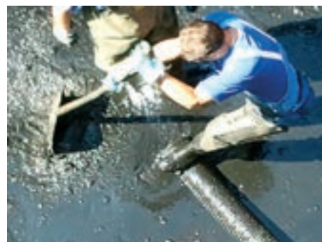
Obr. 4: Čištění nádrží 1
