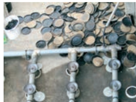
Obr. 10: Demontáž membrán
