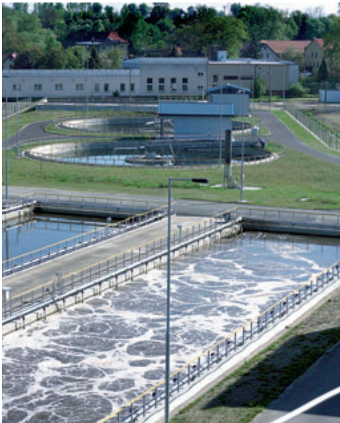
ČOV Cheb – aktivace a dosazovací nádrže, čerpací stanice kalů
