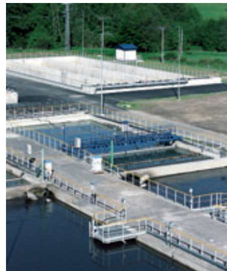
ČOV Cheb – nitrifikace a usazovací nádrž, v pozadí objekt dešťové zdrže
