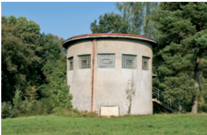
Obr. 4: Čerpací stanice ve Starém Kolíně (foto Pavel Gryč)
