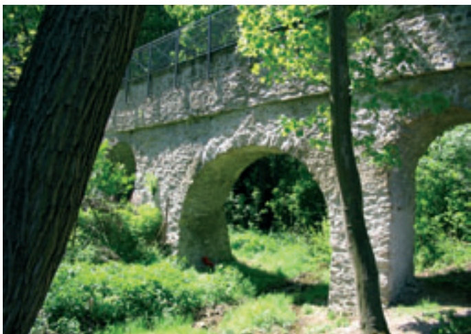
Obr. 3: Akvadukt přes Přítocké údolí (foto archiv VHS)
