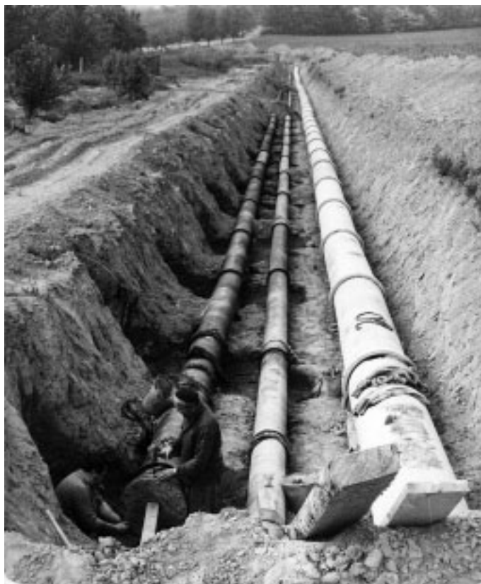
Obr. 6: Stavba přivaděče Kutná Hora – Čáslav – první etapa (foto archiv VHS)
