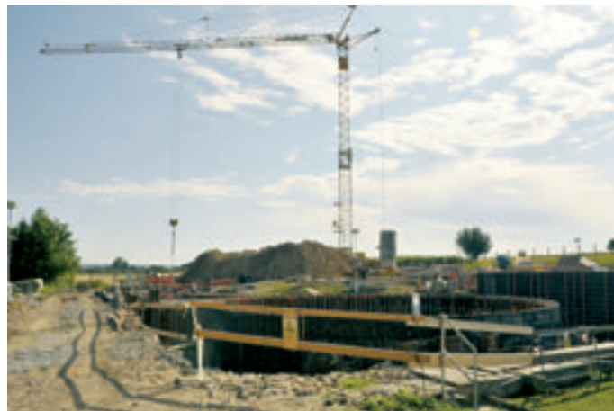
ČOV Čáslav, nově budovaná dosazovací nádrž
